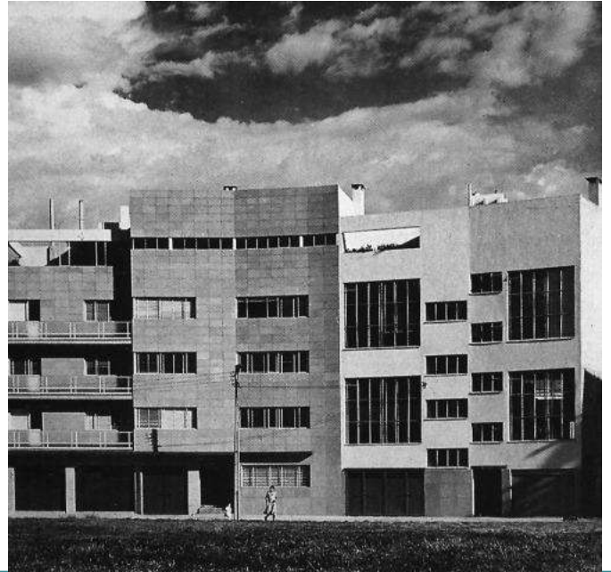
Imagen 40. Edificio Garza (1939) Luis Barragán y José Creixell.
