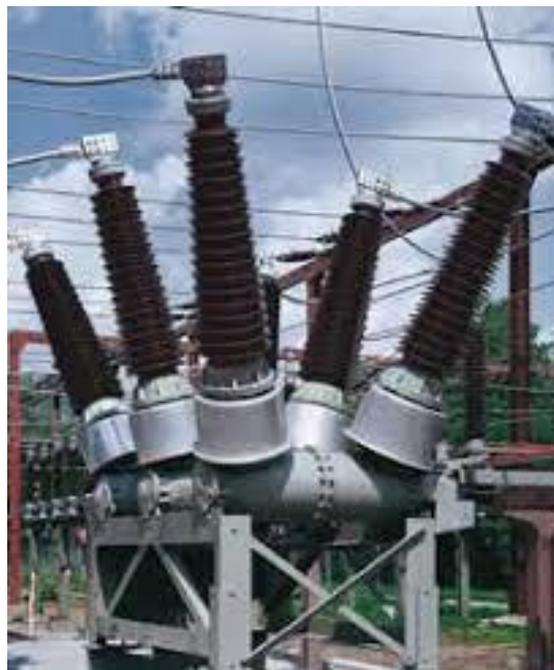
*Figura 2.14* Interruptor aislado en SF<sub>6</sub>. SIEMENS (2013)
