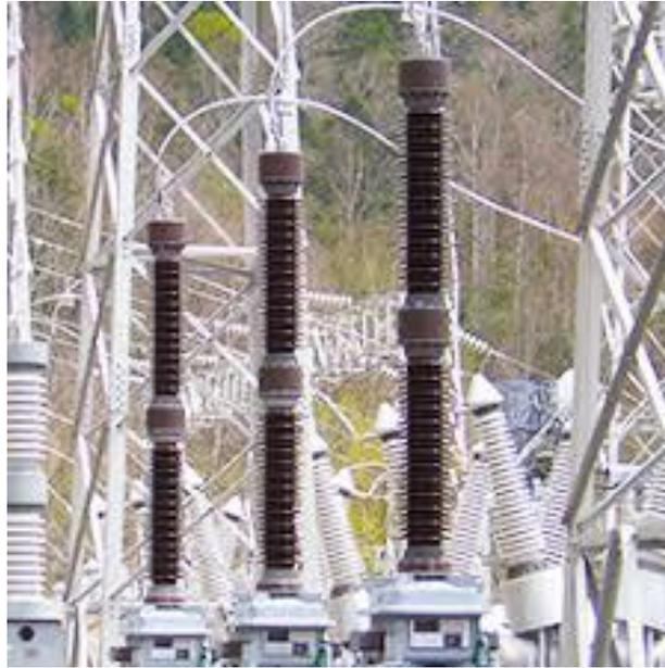
*Figura 2.17* Transformador de potencial. Artech (2020)
