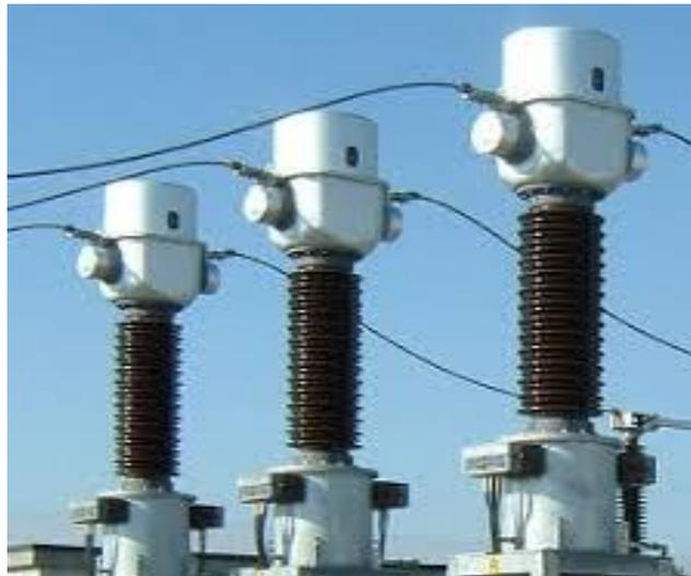
Figura 2.15 Transformador de corriente. Arteche (2020)
