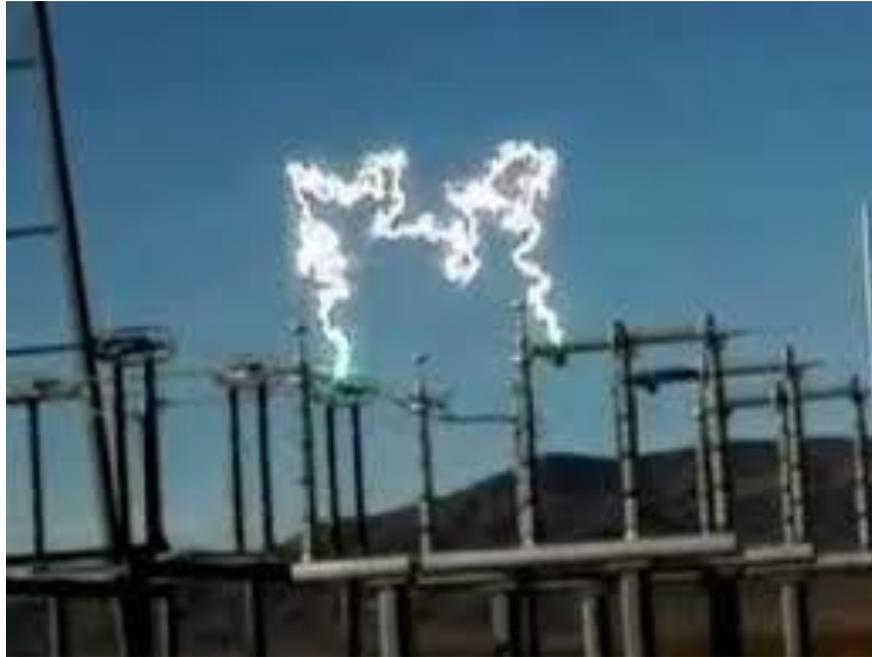
*Fig. 2.8 Surgimiento de un arco eléctrico. Cruz (2013)*
