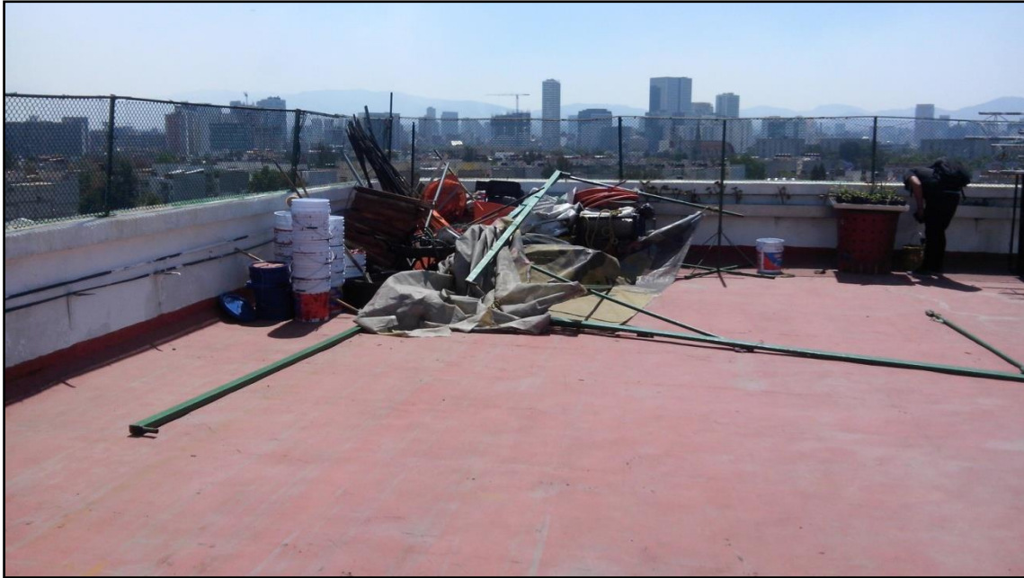
Ilustración 16. Azotea del edificio del G2 antes de la intervención.
