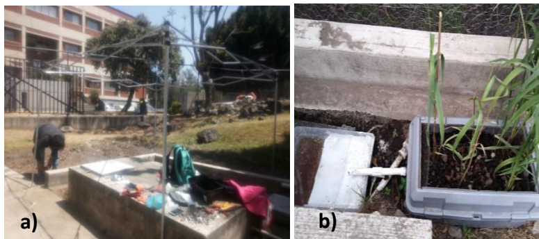
Figura 3. 23 a) Colocación de reja, techo y malla sombra, b) lecho de cal (Fecha: a) 3 de marzo 2019 y b)16 de octubre 2019)
