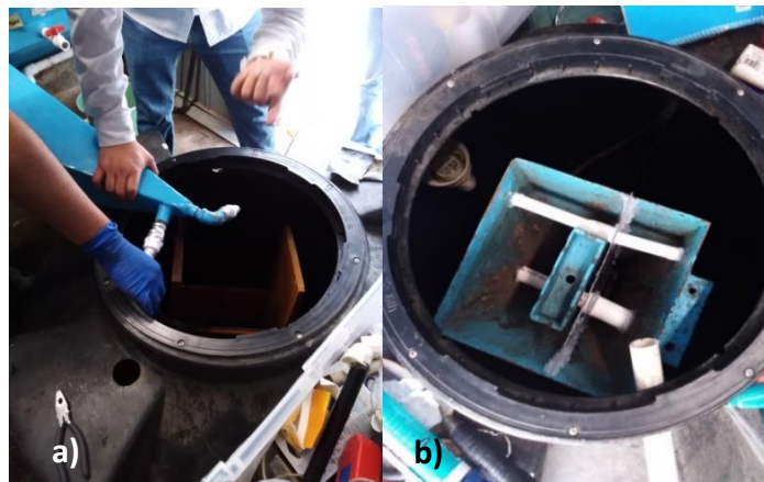
Figura 3. 7 a) Adecuación tubería b) Ajuste y colocación en base de tanque vacío (Fecha: 5 de abril 2019)
