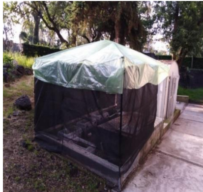
Figura 3. 29 Cambio de cubierta deteriorada por el agua y sol
