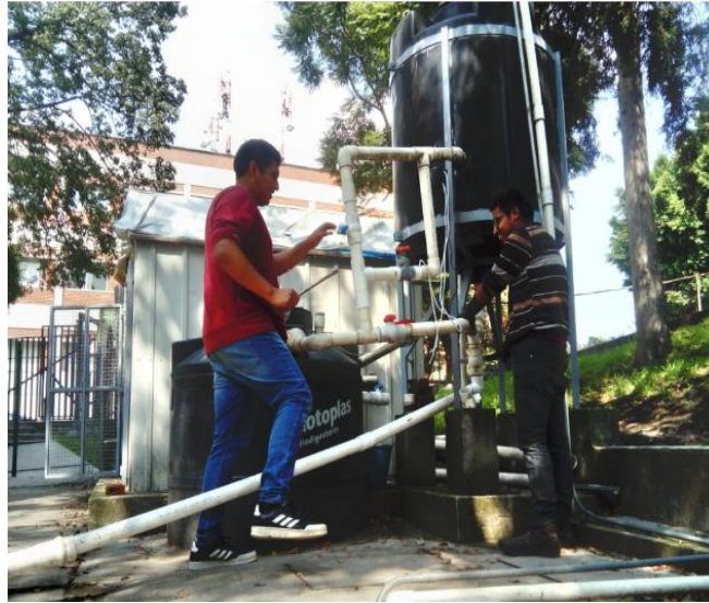
Figura 3. 6 Cambio de válvulas y mantenimiento de PTAR-CBR-DICyG (Fecha: 22 de marzo 2019)
