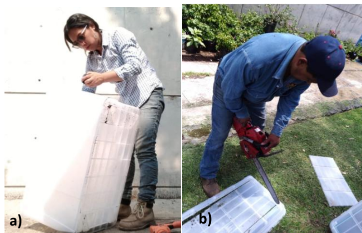
Figura 3. 8 a) Perforación de cajas, b) corte y ajuste de tapas de cajas (Fecha: 8 de marzo 2019)
