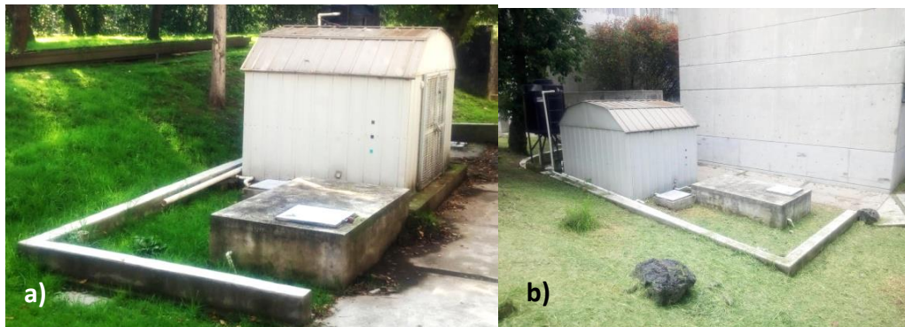
Figura 3.3 a) Vista lateral de la PTAR CBR DICyG, b) Vista desde el Circuito Exterior (Fecha: 21 de septiembre 2018).
