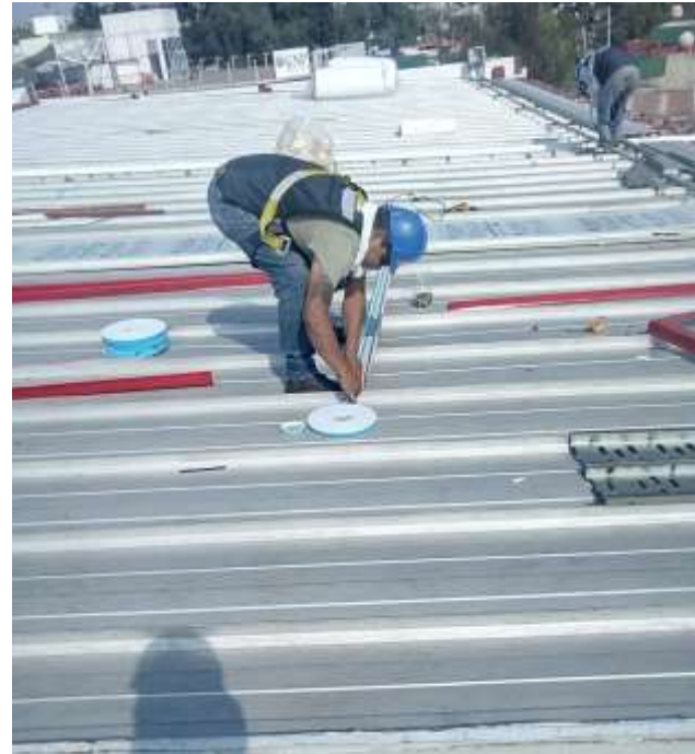
Fotografía 3.- Colocación de pasos de gato.
