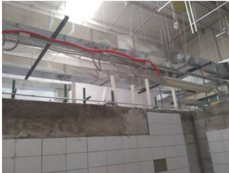
Fotografía 11.- Preparación de instalaciones hidrosanitarias en baños de Asociados.
