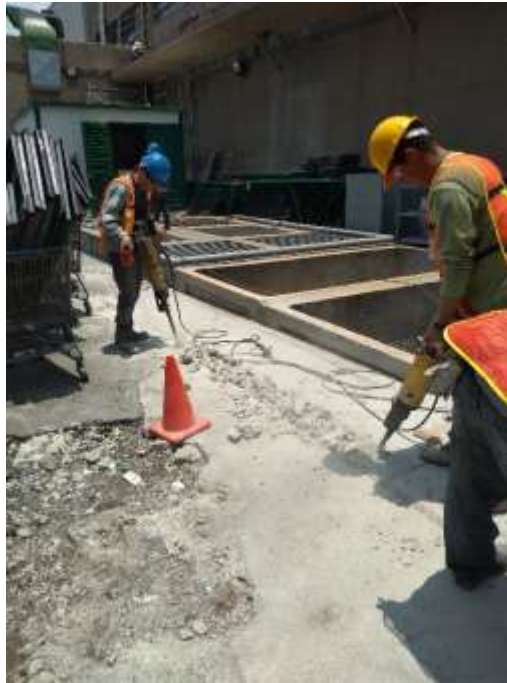
Fotografía 18.- Adecuación de la planta de tratamiento.
