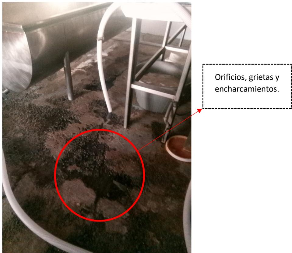
Figura 10. Condiciones actuales de piso en área de producción.
