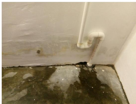
Figura 4. Presencia de coloración extraña en la pared lateral de la cámara de refrigeración.
