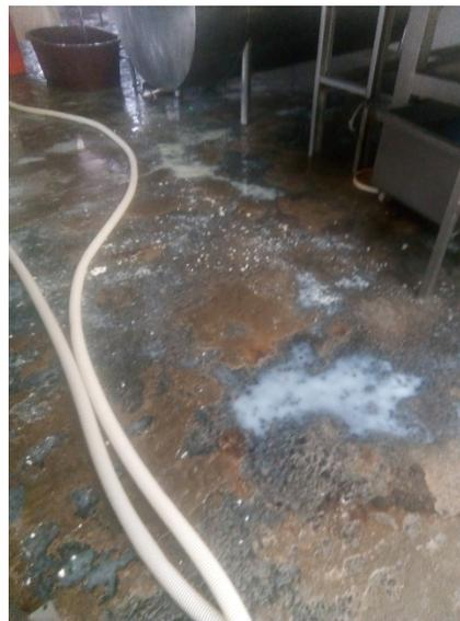
Figura 2. Defectos estructurales de piso con encharcamiento en área de producción.
