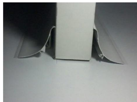
Figura 2. Visualización de curva sanitaria en una instalación.
