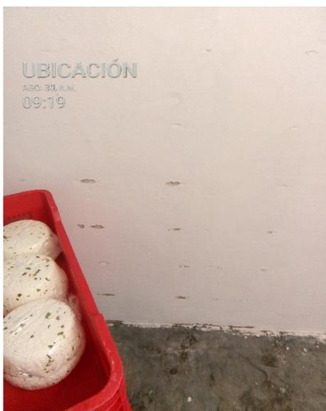
Figura 3. Marcas de golpes en la pared frontal de la cámara de refrigeración.
