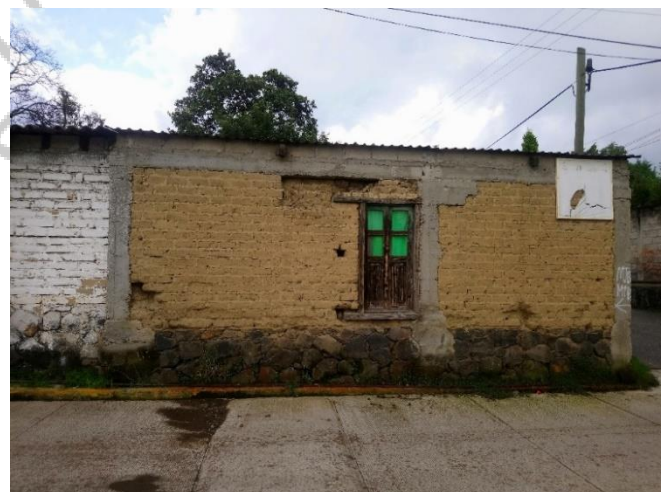
Figura 14. Vivienda de adobe de Ecatzingo, toma frontal de la casa. (agosto, 2019). Fotografía propia.
