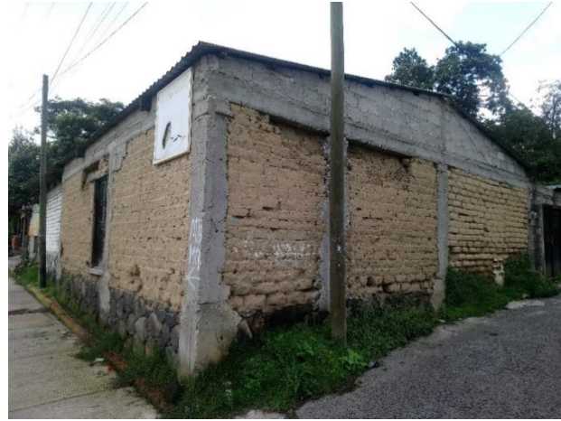
Figura 15. Vivienda de adobe de Ecatzingo, toma lateral de la casa (agosto, 2019). Fotografía propia
