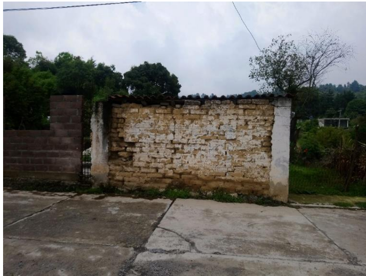
Figura 13. Casa de adobe de Ecatzingo del cuadro municipal. (Agosto, 2019) Fotografía propia
