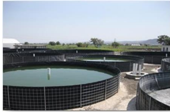
Figura: 6 Estanques de Geomembrana. (GEOSAI 2020).
