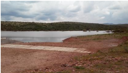
Figura: 1. Bordo de cortina de tierra compactada en Boca del Río, Mpio. Fresnillo, #Zacatecas, tiene una capacidad de 188,913 m3. (CONAZA 2020).
