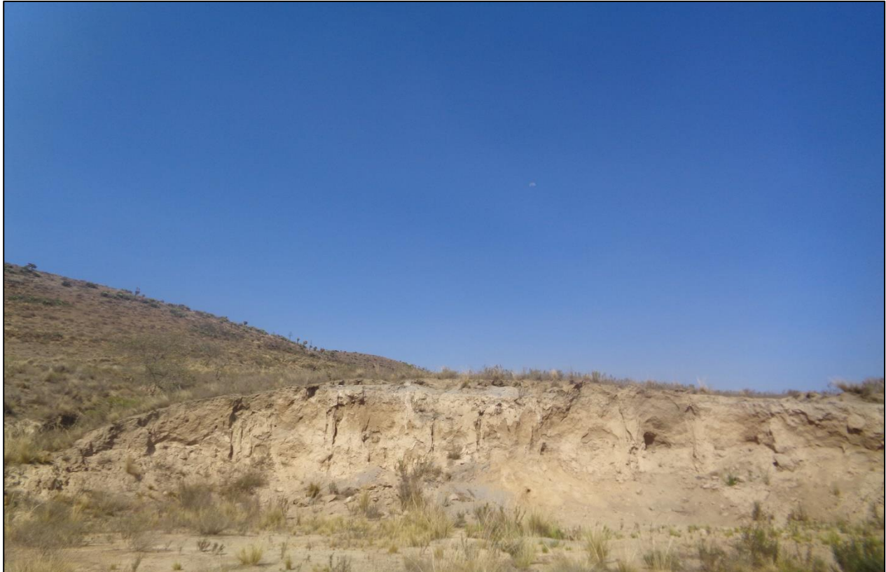
Figura 13. En la presente fotografía se observa la condición física del suelo local, mismo que presenta un color uniforme en la mayor parte del territorio y que se percibe como un suelo poco consolidado, de fácil desprendimiento y endeble ante circunstancias ambientales como la erosión o las fuerzas pluviales de gran magnitud.
