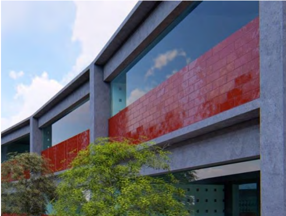
Figura 28 Vista de muros exteriores en edificio de Aulas
