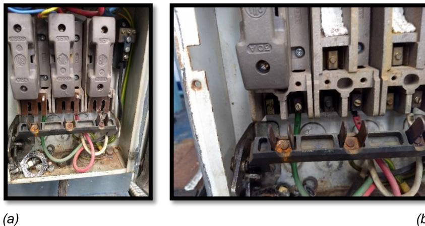
**Figura 7. Anexo A. Tablero de cuchillas.** (a) y (b) se muestran las cuchillas sucias y oxidadas. (Elaboración propia)
