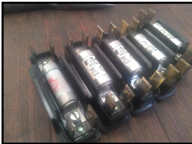
**Figura 7. Anexo B. Revisión de la instalación eléctrica. Eliminación del “diablitos” por fusibles en los arrancadores. (Elaboración propia)**
