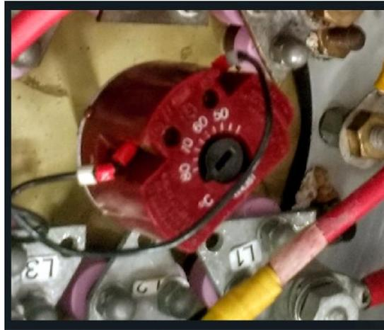
**Figura 22:** Termostato de las resistencias eléctricas. (Elaboración propia)
