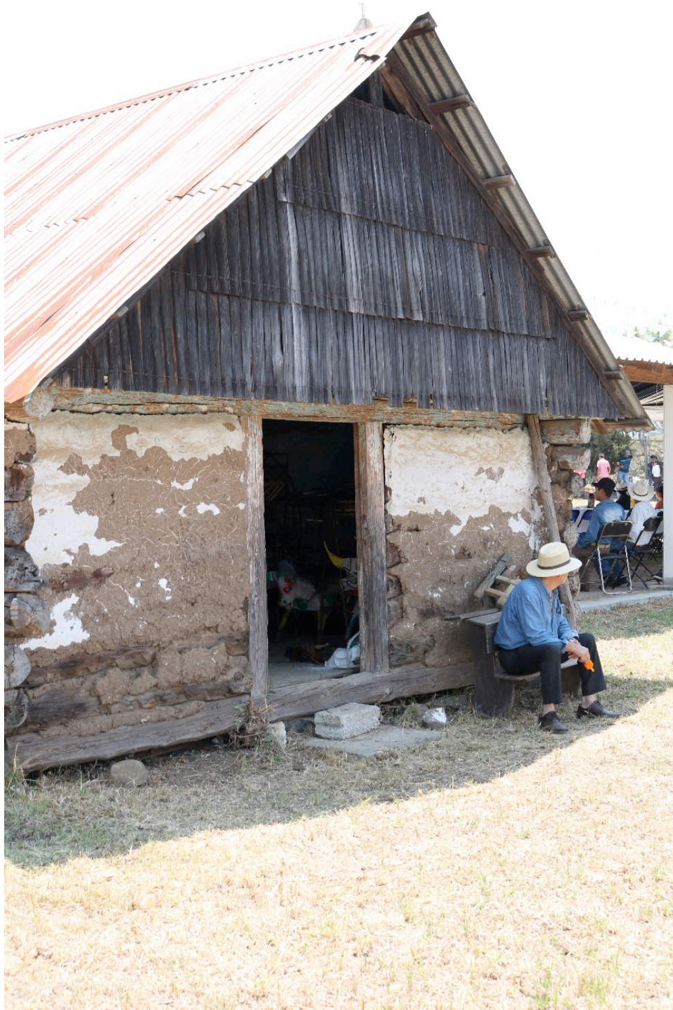
Imagen 16 (Antigua iglesia de Cieneguillas, aún conserva el aplanado con la mezcla de tierra, agua y paja)
