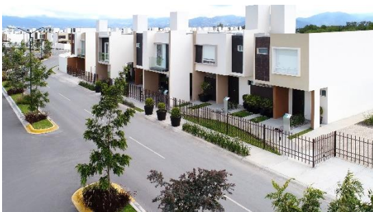
Zona residencial Paseo Arboleda.
