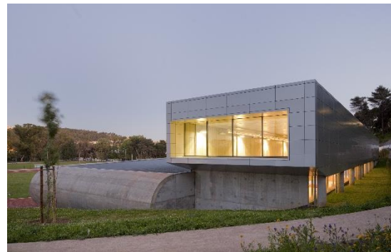
Centro de alto rendimiento, Jamor, Portugal.
