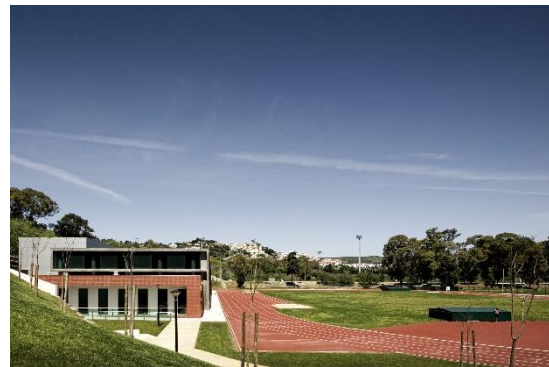
Centro de alto rendimiento, Jamor, Portugal.
