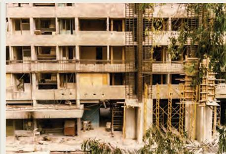
**Fig.H.** Cartelas de concreto se cimbraron para contener las columnas originales. Este elemento es notorio en los edificios tipo C, que le brinda una silueta más brutalista, y menos similar al funcionalismo original que Mario Pani diseñó.
