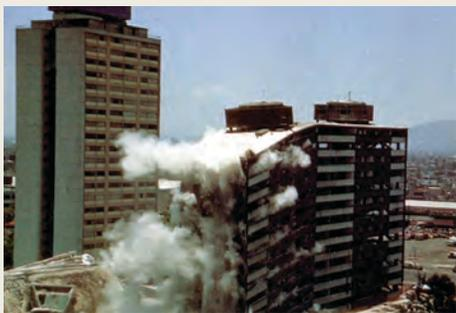
**Fig.D.** El edificio tipo I Guelatao es derrumbado con el método de implosión controlada. Se agregaron explosivos en las columnas dañadas para realizar el proceso.
