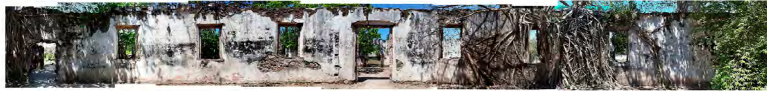
C LARGUILLO FOTOGRÁFICO DE CRUJÍA PRINCIPAL EN EJE C VISTO DESDE EL INTERIOR DE LA MISMA.
