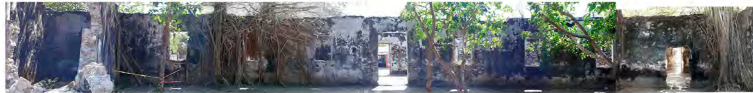
D LARGUILLO FOTOGRÁFICO DE CRUJÍA PRINCIPAL EJE C VISTO DESDE EL PATIO INTERIOR
