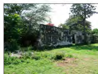
17 VISTA CRUJIA POSTERIOR DESDE PATIO. 2
