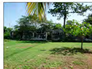
16 VISTA CRUJIA POSTERIOR DESDE PATIO
