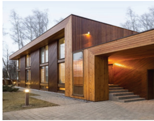
Fig. 12. Acabado en Fachada. [I-12].
