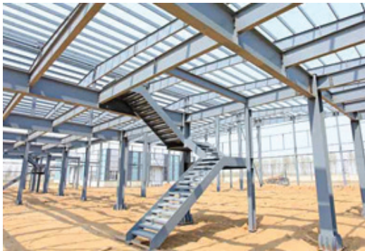
Fig. 17 Estructura metálica [I-17]
