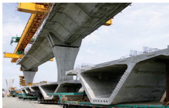
Fig. 11. Puentes de concreto (aplicación del concreto en ingeniería) [I-11]
