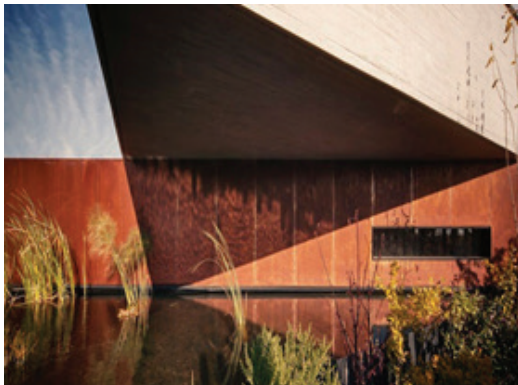
Fig. 18 Acero Cor-Ten en Fachada [I-18]
