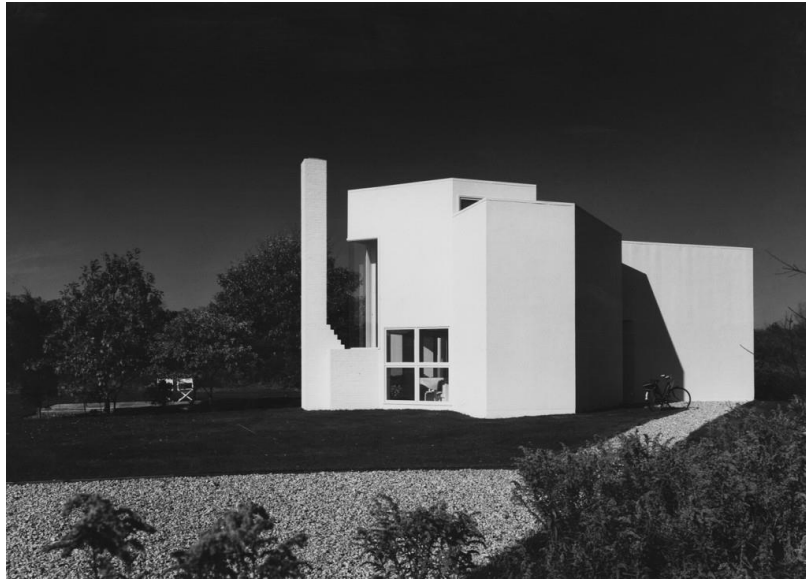
Imagen 93 Fachada a la calle Consultada en: http://www.richardmeier.com/?projects=hoffman-house
