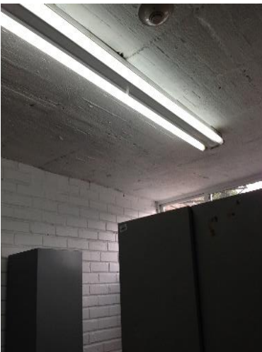
Fig.4 Luminarias sin sensor de presencia, modelos de consumos altos energéticos en área de vestidores CEDIS.
