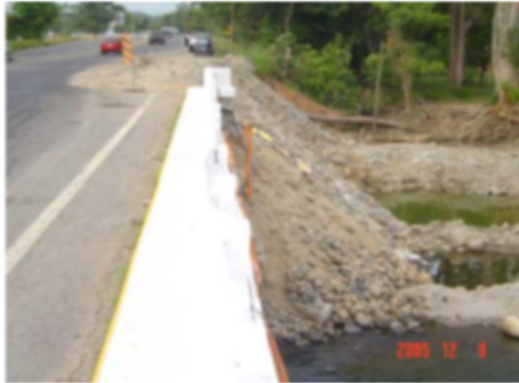
Figura 2.8. Zona del puente con trabajos de reconstrucción (Rivera, Echavarría y Pacheco, 2006)
