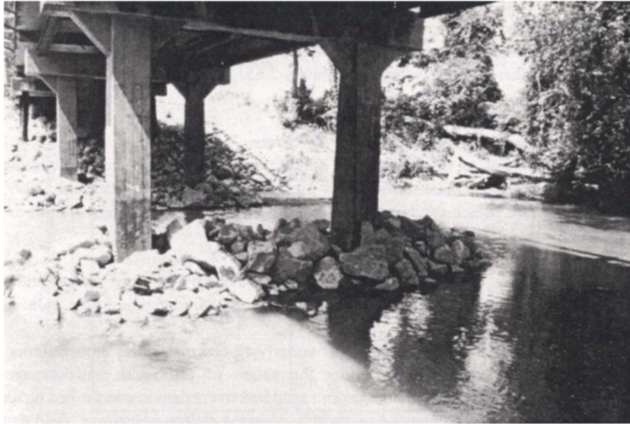
Figura 4.14. Pilas de puente protegidas con enrocamiento (Dos Santos, 2008)
