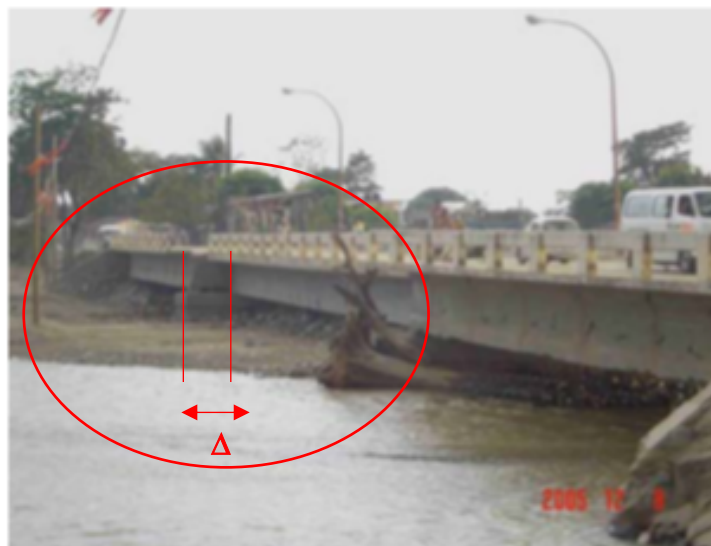
Figura 2.2. Movimiento de translación de la superestructura ante el paso de la avenida (Rivera, Echavarría y Pacheco, 2006)
