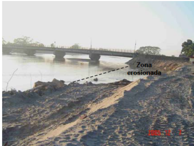
Figura 2.4. Erosión del terreno a causa de la corriente del río durante el paso del huracán Stan (Rivera, Echavarría y Pacheco, 2006)
