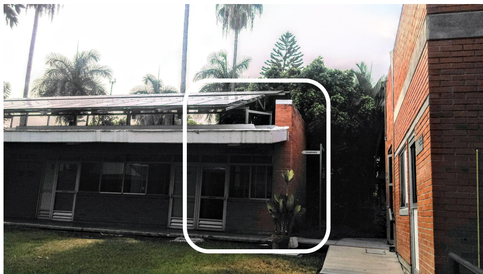
Figura A-2: Vista de la fachada sur del cubículo D7.
