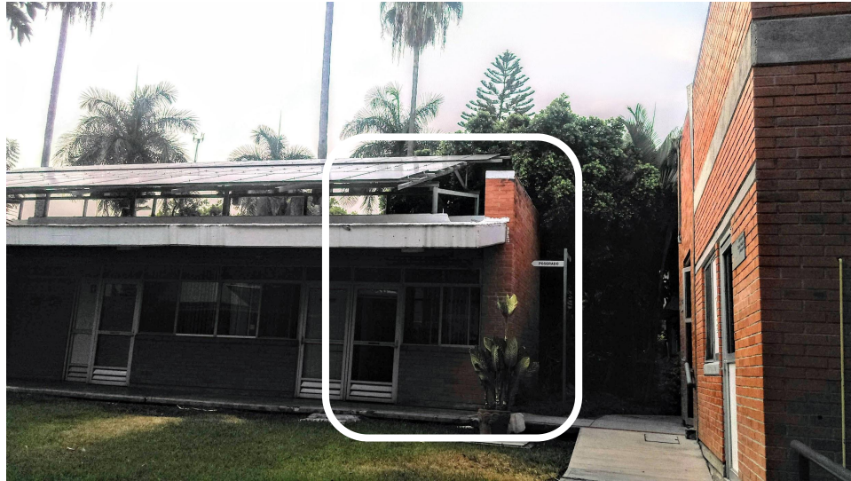
Figura 3-1: Fachada sur del cubículo D7.
