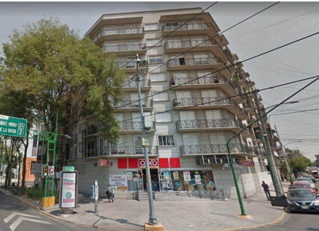
Fuente: "Foto tomada en sitio."
