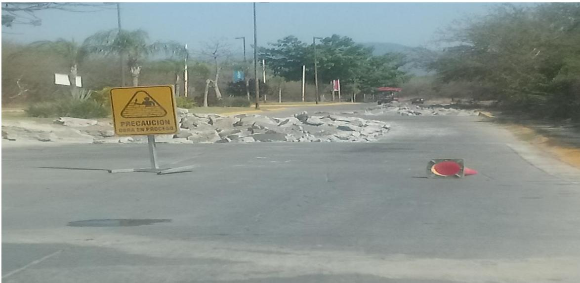
Figura 15. En esta imagen se muestra una de las constantes averías que sufre el pavimento en la avenida Altavela, vía principal para acceder al fraccionamiento del mismo nombre. Los caminos de esta urbanización constantemente se encuentran en reparación debido a los socavones y hundimientos que se presentan en la carpeta asfáltica. Fuente: Fotografía de la autora, realizada el martes 14 de mayo del 2019.
