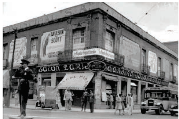
La casona en 1925, próxima a su demolición. (2018) Recuperado de https://www.edemx.com
