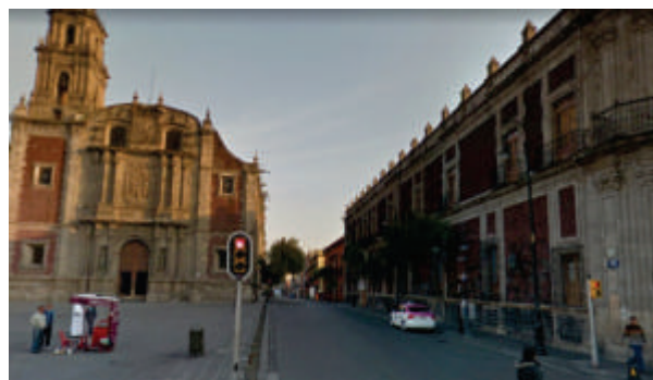
Vista parcial de la plaza de Santo Domingo, desde la calle República de Brasil hacia la Lagunilla. (2019) Recuperado de https://www.google.com/maps
