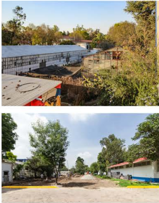
Im6genes 10, 11. Estado del terreno antes y despu6s de remover edificaciones.
