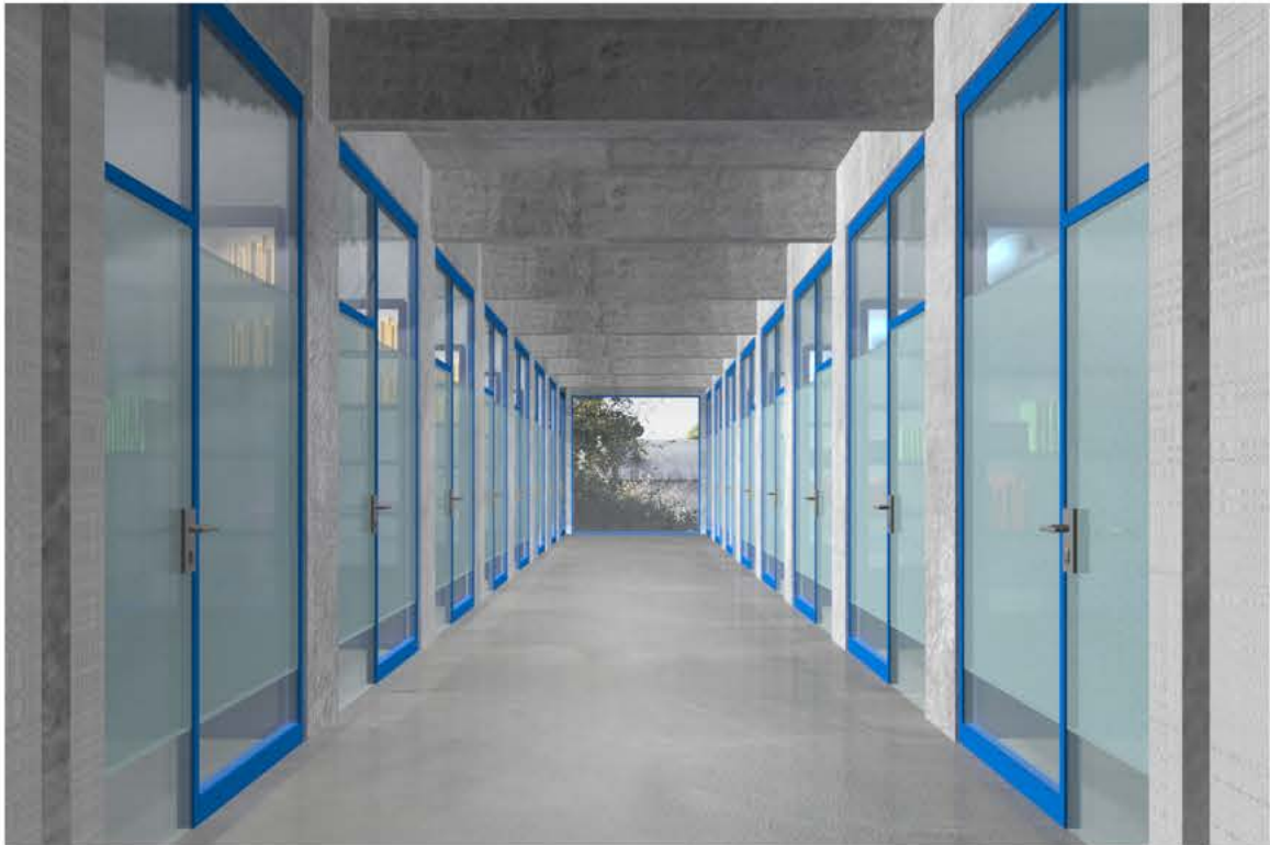
Pasillo Zona de cubículos
