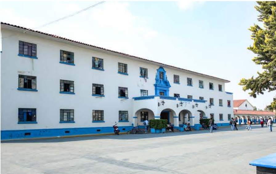
Imagen 17. Fachada principal de un edificio de dormitorios. También se visualiza uno de los corredores del patio de honor al fondo.
