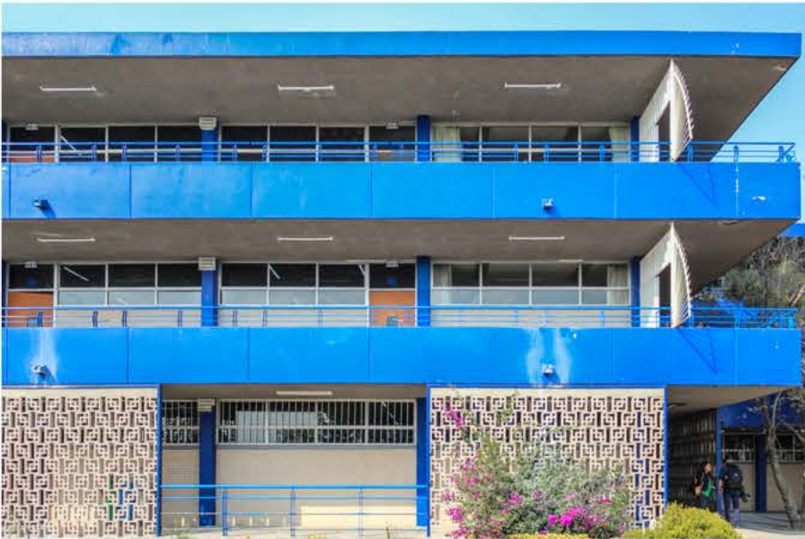
Imagen 23. Fachada de un edificio de aulas de la preparatoria visto desde el circuito periférico.
