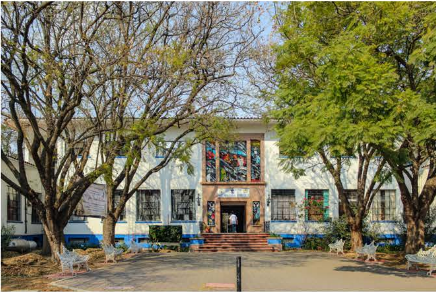
Imagen 19. Fachada sur del departamento de preparatoria agrícola
