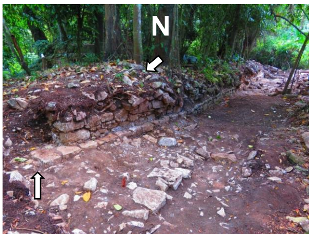
Figura 4.7. Una vez escombrado toda la sección oeste de J3 fue posible apreciar el muro posterior de la estructura. Nótese la esquina NW del edificio. Fotografía del autor.
