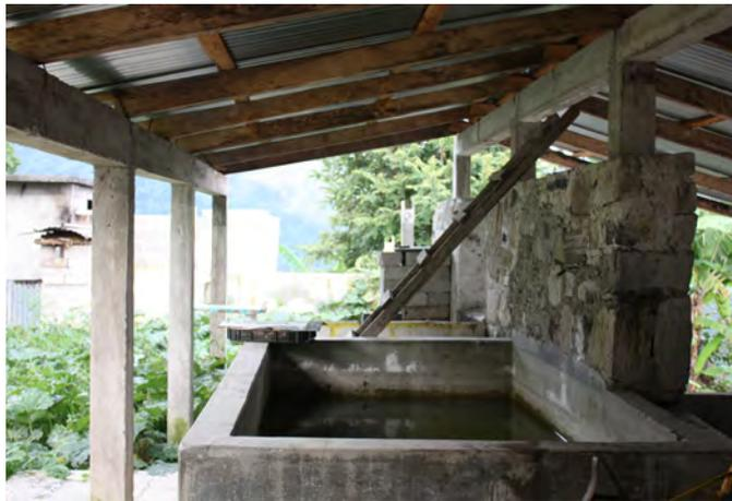
Fig.43 Fotografía del tanque de decantado
