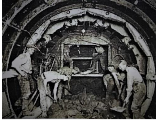
Figura 2.5 Escudo de Greathead (sección circular y el sostenimiento con anillos metálicos). (GUGLIELMETTI ET AL., 2007)
