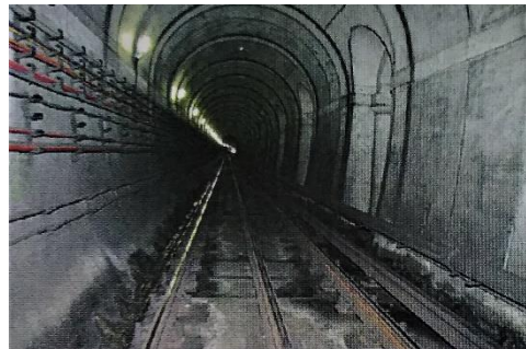
Figura 2.2 El Túnel bajo el Támesis que es aún parte del "East London Metro Line". (GUGLIELMETTI ET AL., 2007)
