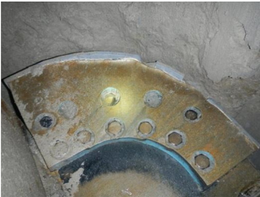
Figura 3.30 Ejemplo de rastrel empleado en el tramo 3 del TEO. (CARSO, 2013)
