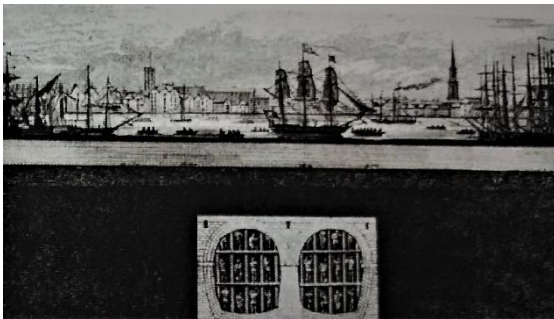
Figura 2.3 El escudo de Brunel en acción bajo el Támesis (MATHEWSON ET AL. 2006), recuperado de (GUGLIELMETTI ET AL., 2007)
