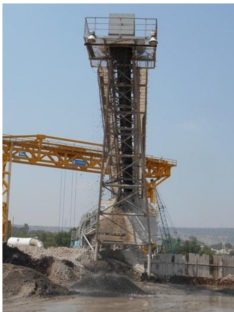
Figura 4.20 Rezagado del material en la lumbrera 21A con gran cantidad de agua. (Cortesía de COMISSA)
