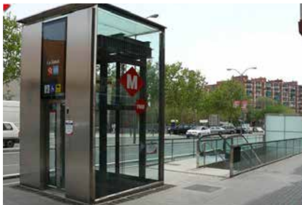
Ilustración 38- Ascensor para acceder a estación de metro (Trens de Catalunya)
