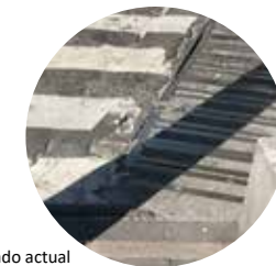
Registro y estado actual de los pavimentos.
