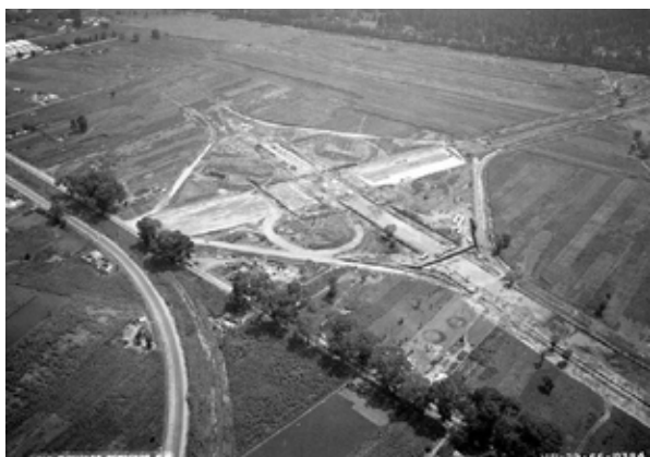
Ilustración 12 Vista aérea de construcción de Anillo Periférico en 1966, Av. Tlalpan y Av. Periférico (Cinta, 2018)
