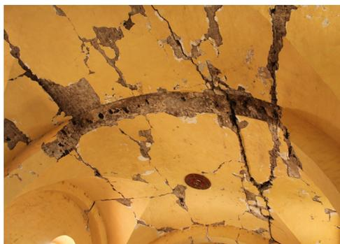
Fig. 5.4 a) Agrietamiento en bóveda y arco fajón colapsado. foto 2018.
