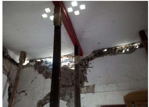
Fig.4.17 Techumbre de concreto armado sobre los muros de tezontle.
