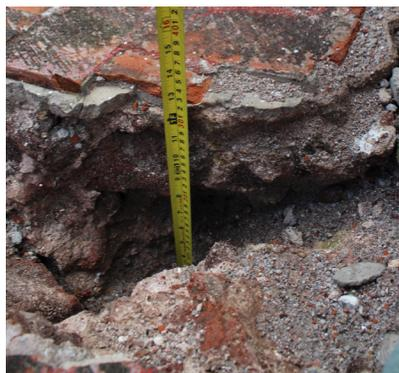
Fig 2.46. Medición del espesor de semicúpula.
