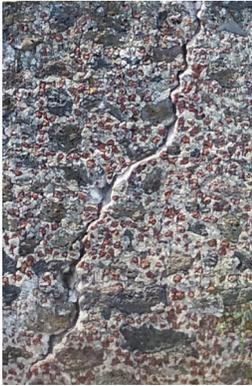
Fig.4.11 Grietas diagonales debido al cortante, presentes en muros debajo de ventanas, zona del presbiterio.
