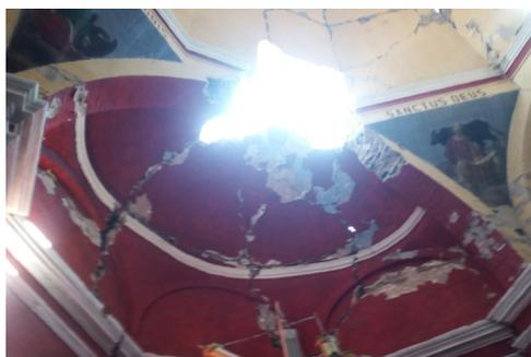
Fig. 5.3 a) Zona de la clave en arco trinfual colapsado, foto 2017.
