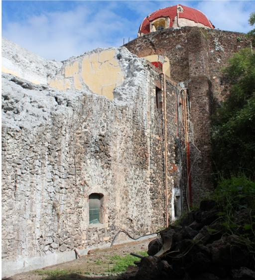
Fig.4.14 Colapso fuera del plano de segundo nivel del convento.
