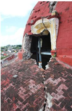
Fig.4.12 Colapso de sección de cúpula octagonal y semicúpula.
