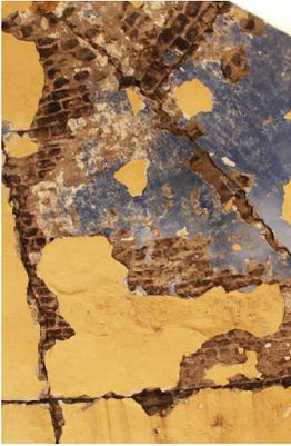
Fig 2.37. Intradós de la cúpula, hiladas horizontales visibles en uno de los gajos que coincide con las grietas horizontales. , foto 2018.
