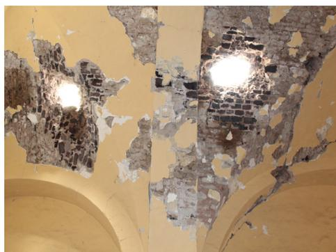
Fig. 5.1 a ) Perforaciones en bóveda sobre el coro . foto 2018.
