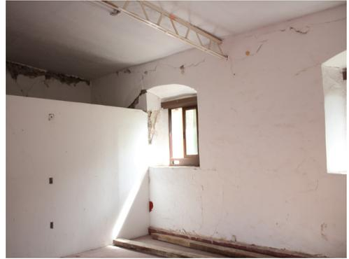
Fig.4.15 Techumbre de concreto armado que favoreció el colapso fuera de plano del muro del segundo nivel.
