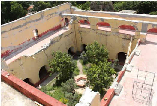
Fig.4.16 Colapso fuera de plano de arcada en claustro alto del convento.
