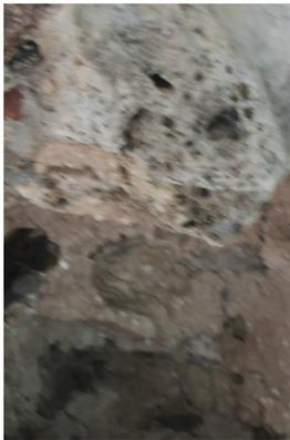
Fig 2.48. Mampostería del contrafuerte, con presencia de nódulos de cal.
