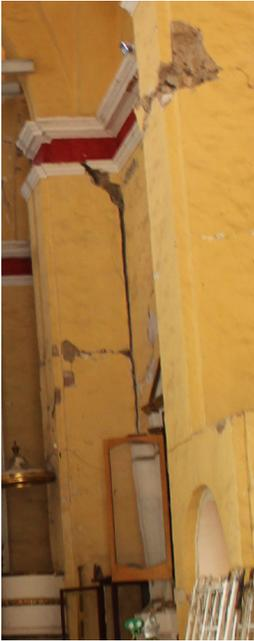
Fig. 2.23 Pilastra separada de muro del templo. Fotografía del autor 2018.
