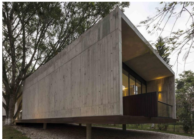
Fig. 81 Exterior de la Casa del abuelo en donde se observa el uso de muros de concreto armado aparente con la textura de la cimbra, una cubierta de concreto armado y ventanales con cancelería de aluminio esmaltado en color negro. Fuente: ArchiDaily México.
