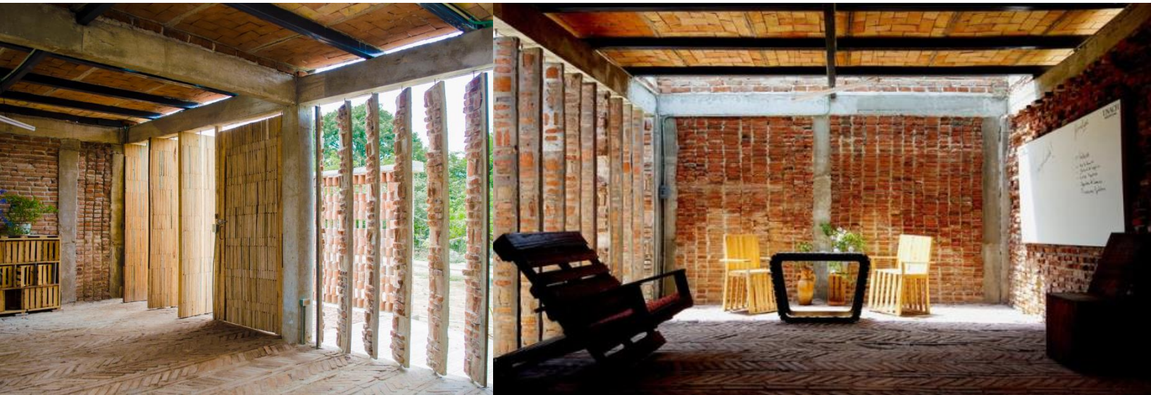
Fig. 85 Imágenes del proyecto, se observa el uso de marcos rígidos de concreto armado. Fuente: ArchiDaily México.
