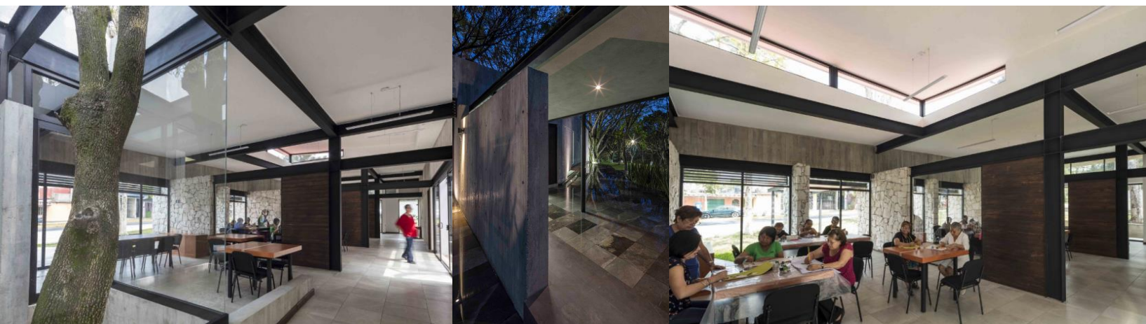
Fig. 82 Interior de la Casa del abuelo con vistas hacia la zona de talleres. Se puede notar un sistema constructivo a base de columnas y vigas de perfil de acero tipo IPR, muros divisorios de piedra, concreto o madera, aparte del uso de loseta de cerámica. Fuente: ArchiDaily México.
