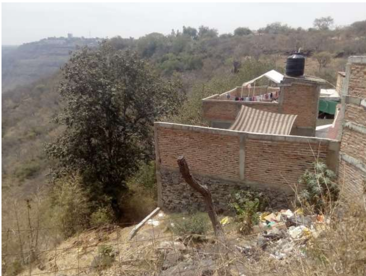
Figura 05.26: Ejemplo de cimentación elevada en el área de estudio. Fuente: Arias Martínez A. (Fotografía Documental Amateur. Marzo, 2020)
