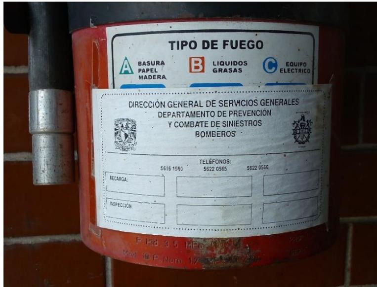
**Figura 8.** Fotografía de la etiqueta de revisión del extintor.
