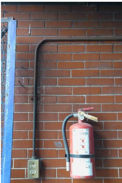
**Figura 22.** Extintor sin señalización.
