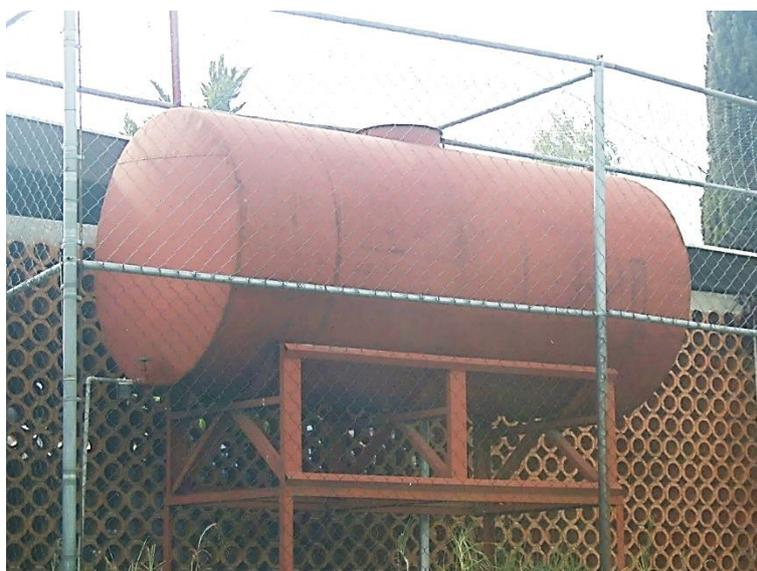
**Figura 15.** Fotografía del tanque de almacenamiento de diesel.
