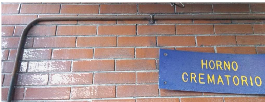
**Figura 21.** Tubería sin señalización.
