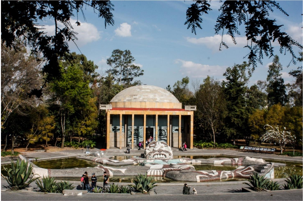
61. Cámara de Distribución del Agua del Lerma. Fuente: Colección del autor, A. Itzel, 2020.
