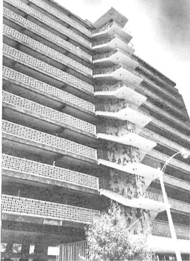
48. Centro Urbano "Presidente Juárez", detalle de la decoración en las escaleras. Fuente: Arquitectura México 67, septiembre de 1959.
