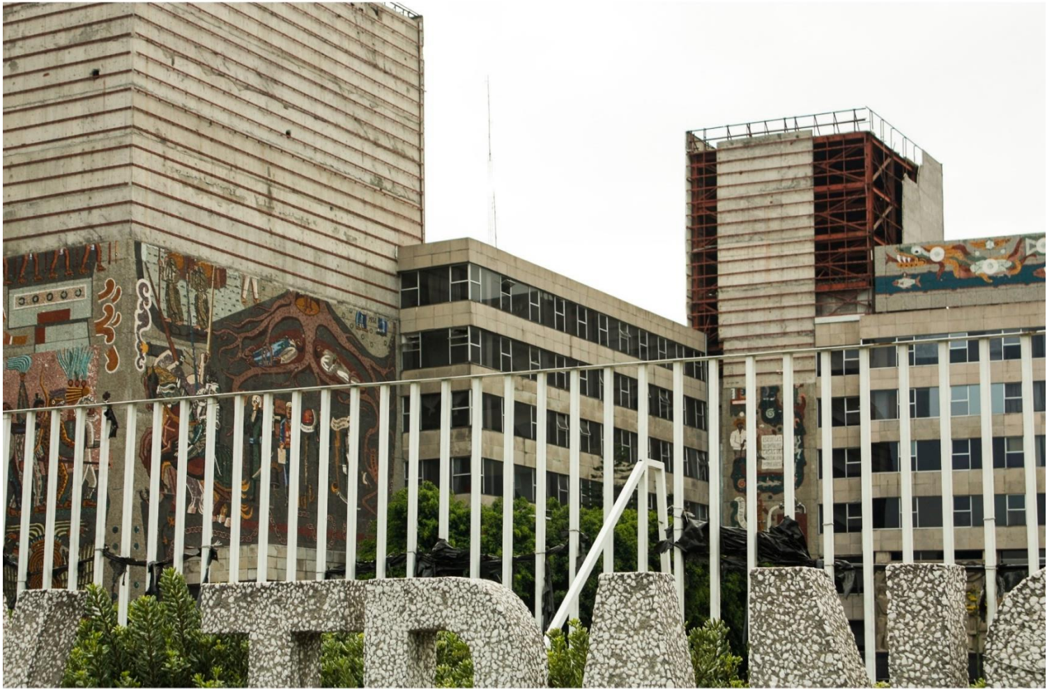
25. En la actualidad se están retirando los murales del Centro SCOP para su resguardo, debido a los daños estructurales de los edificios, a partir de los sismos de 1985 y 2017. Fuente: Colección del autor, A. Itzel, 2020.
