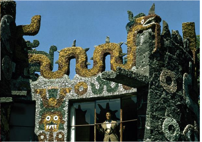
112. Casa del Pedregal. Fuente: UFE, 19 de enero de 1959.
