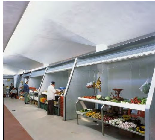
Gráfico 46. Locales del Mercado de Santa Ana, 2020. Gráfico recuperado de: Mexican Architects-Duarte Aznar, https://www.mexican-architects.com/es/duarte-aznar-arquitectos-merida/project/mercado-del-barrio-de-santa-
