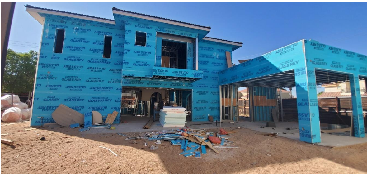
Imagen 17 Acabado exterior cubierto con hoja denglass,
