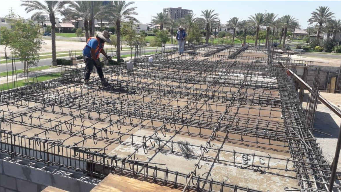
Imagen 26 Armado y colocación de acero para losa de entrepiso.
