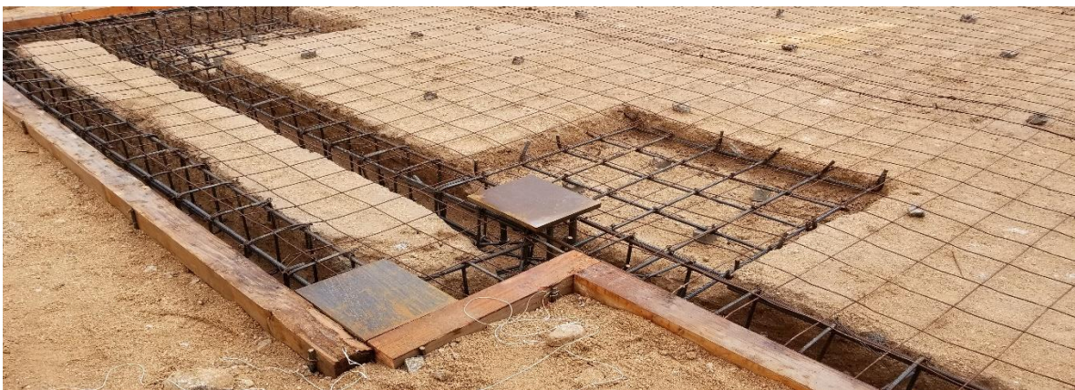
Imagen 1 Colocación de placas base para columnas principales.
