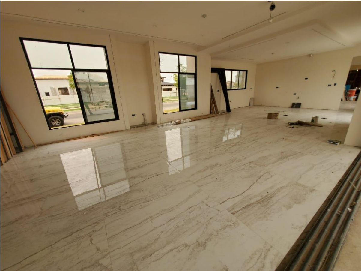
Imagen 35 Acabados interiores con yeso y pintura interior.
