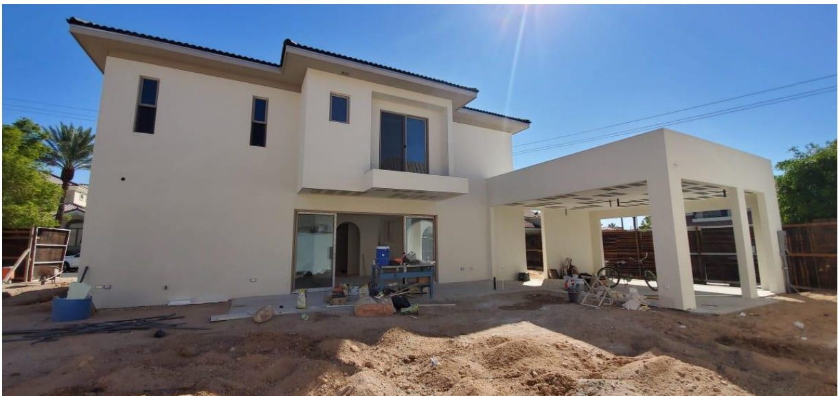
Imagen 18 Acabado final con aislante y pintura exterior.
