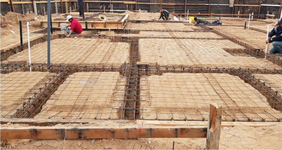
Imagen 2 Colocación de acero de refuerzo para cimentación.
