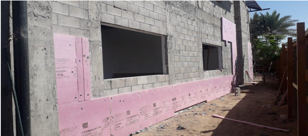
Imagen 36 Fijación de hoja de poli estireno extruido sobre muro de block
