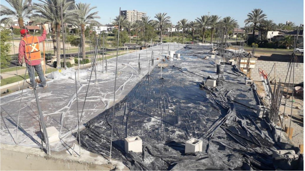
Imagen 28 Curado de concreto en losa de entrepiso con barrera de vapor.
