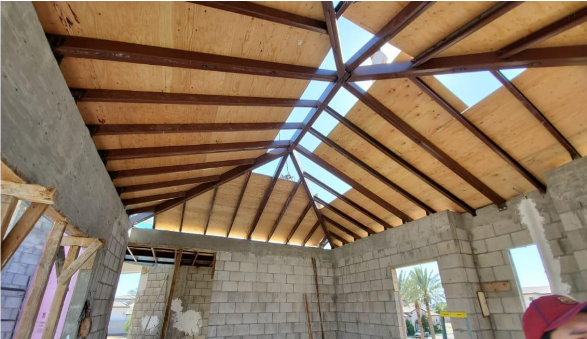
Imagen 30 Colocación de triplay de petatillo sobre estructura de polines.
