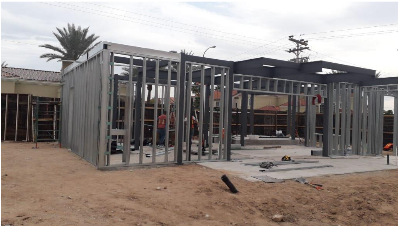
Imagen 7 Armado de muros sobre estructura principal
