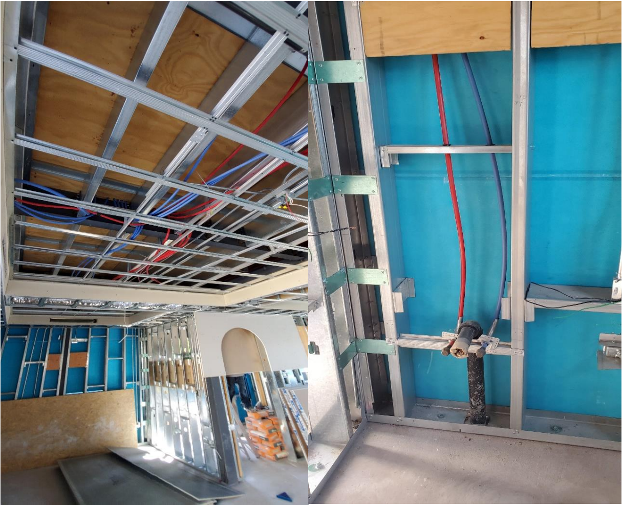
Imagen 12 Instalación de mangueras para red hidráulica interior.
