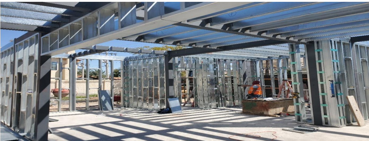
Imagen 9 Colocación de canales de acero para entepiso
