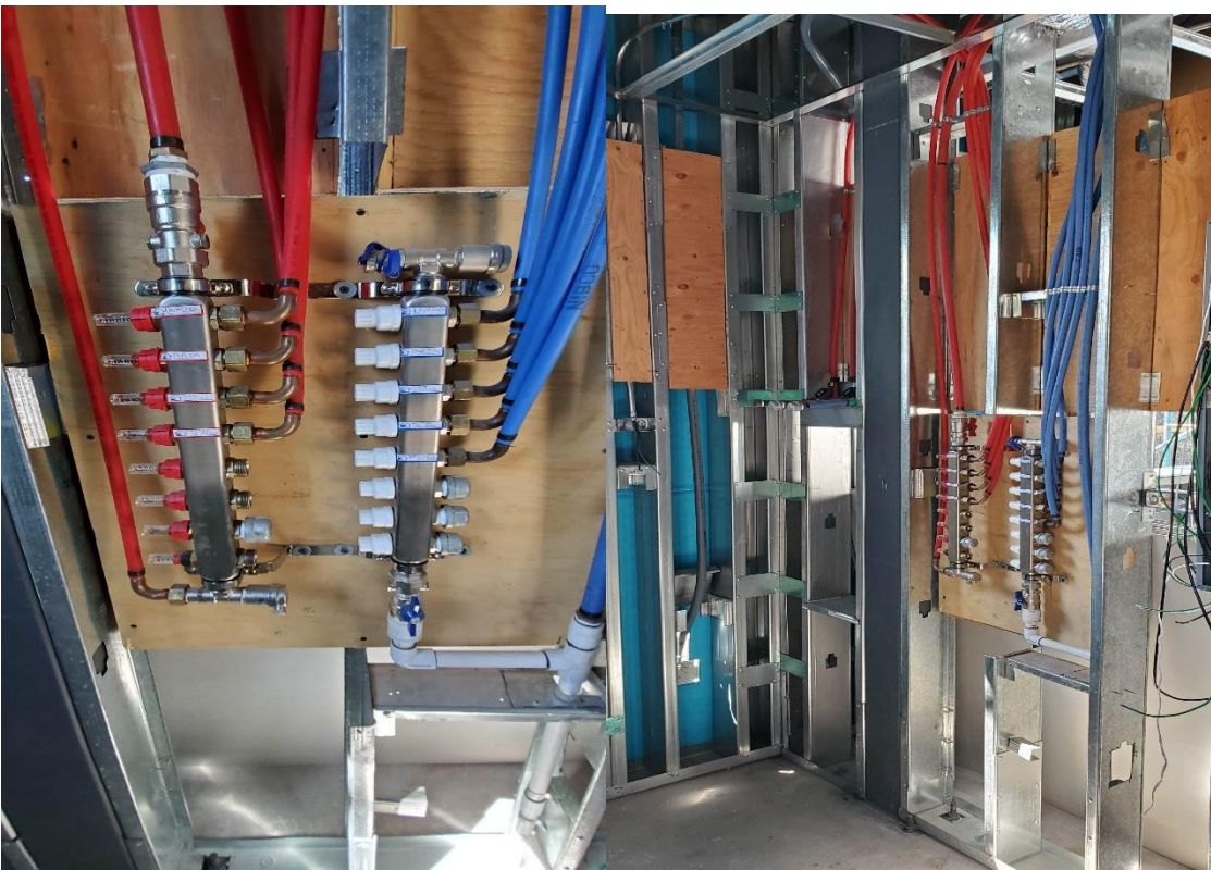
Imagen 11 Instalación de manifolds.
