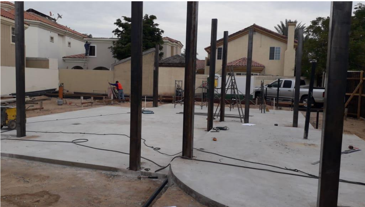
Imagen 4 Montaje de columnas principales.
