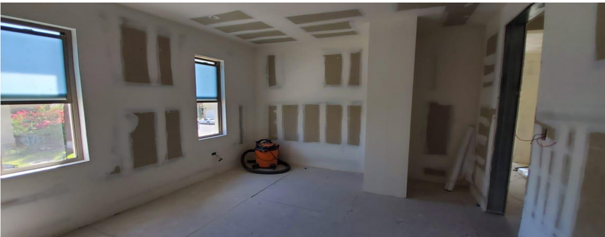
Imagen 16 Acabados interiores en muros , antes de pintura interior.
