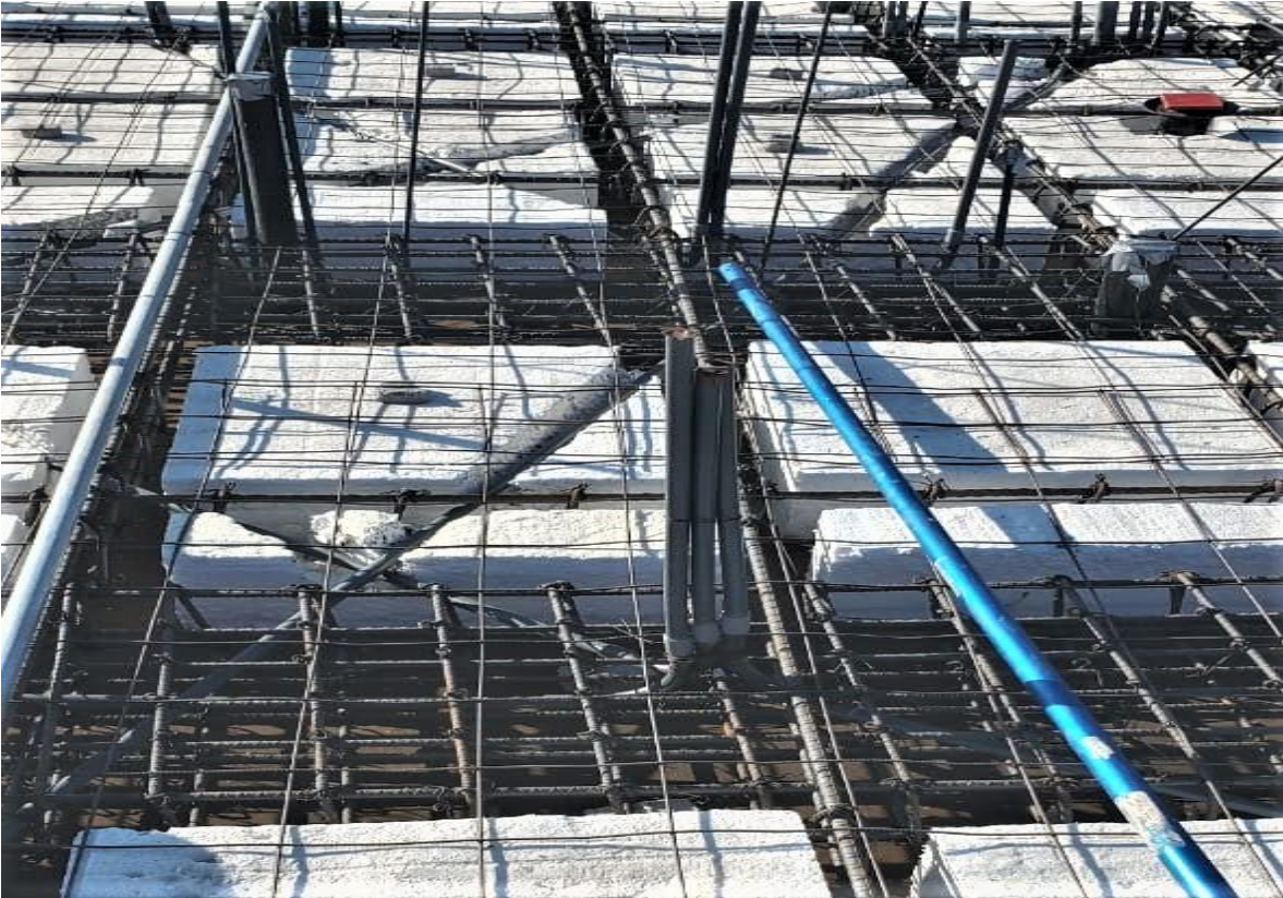
Imagen 33 Tuberías de PVC para instalaciones eléctricas que quedaran dentro de la losa de entrepiso.
