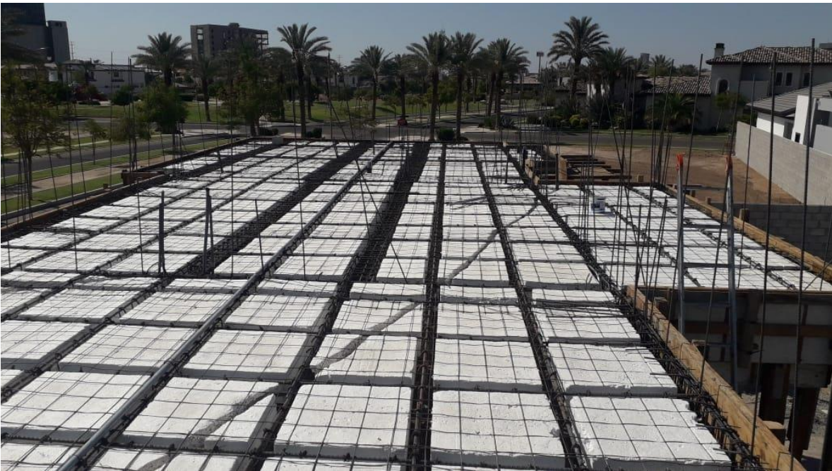
Imagen 27 Sistema de losa nervada para entrepiso.
