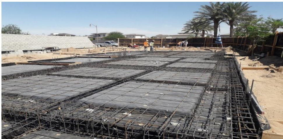
Imagen 19. Colocación de acero de refuerzo para cimentación.
