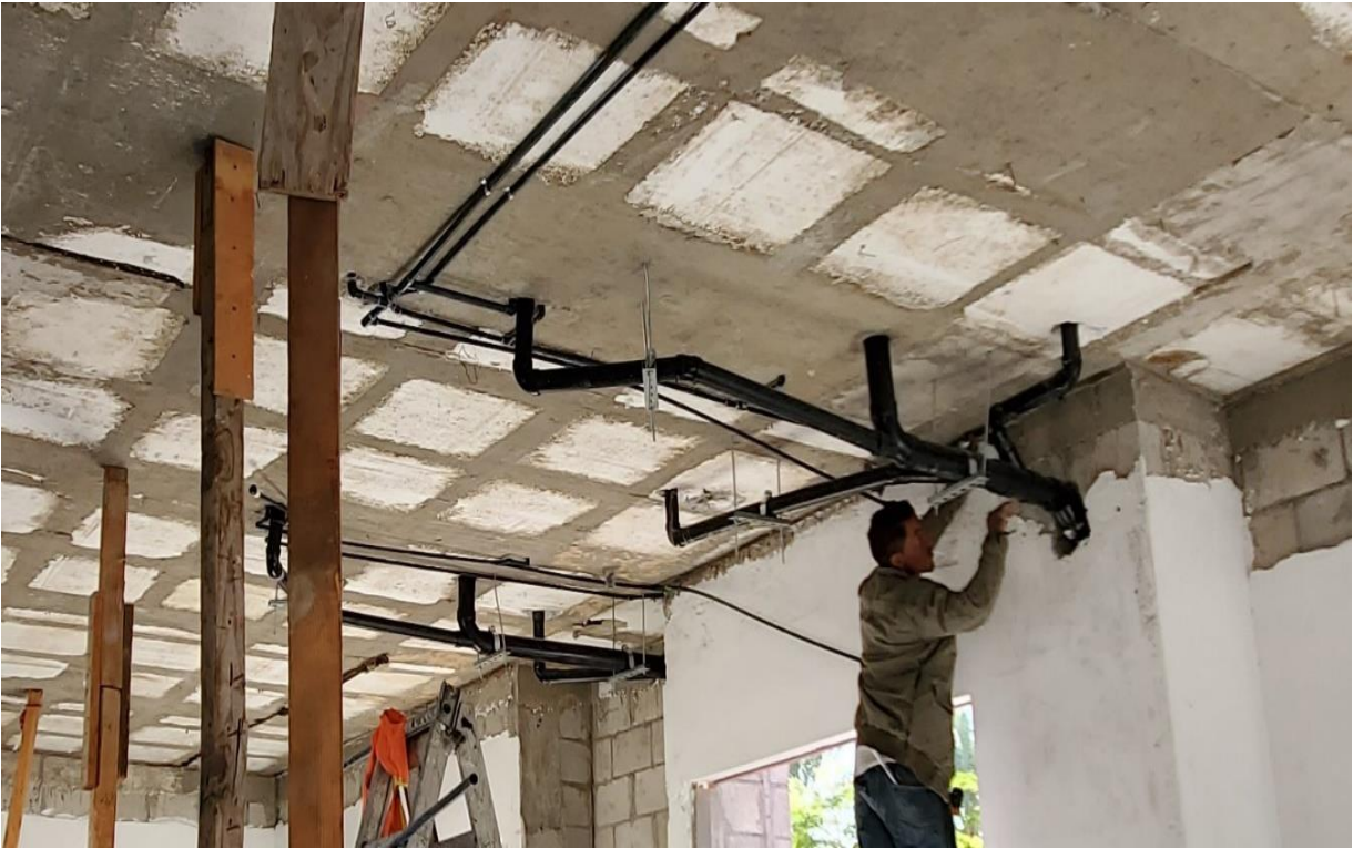
Imagen 32 Fijación de tuberías hidráulicas mediante tornillos sin fin y abrazaderas al lecho inferior de losa.
