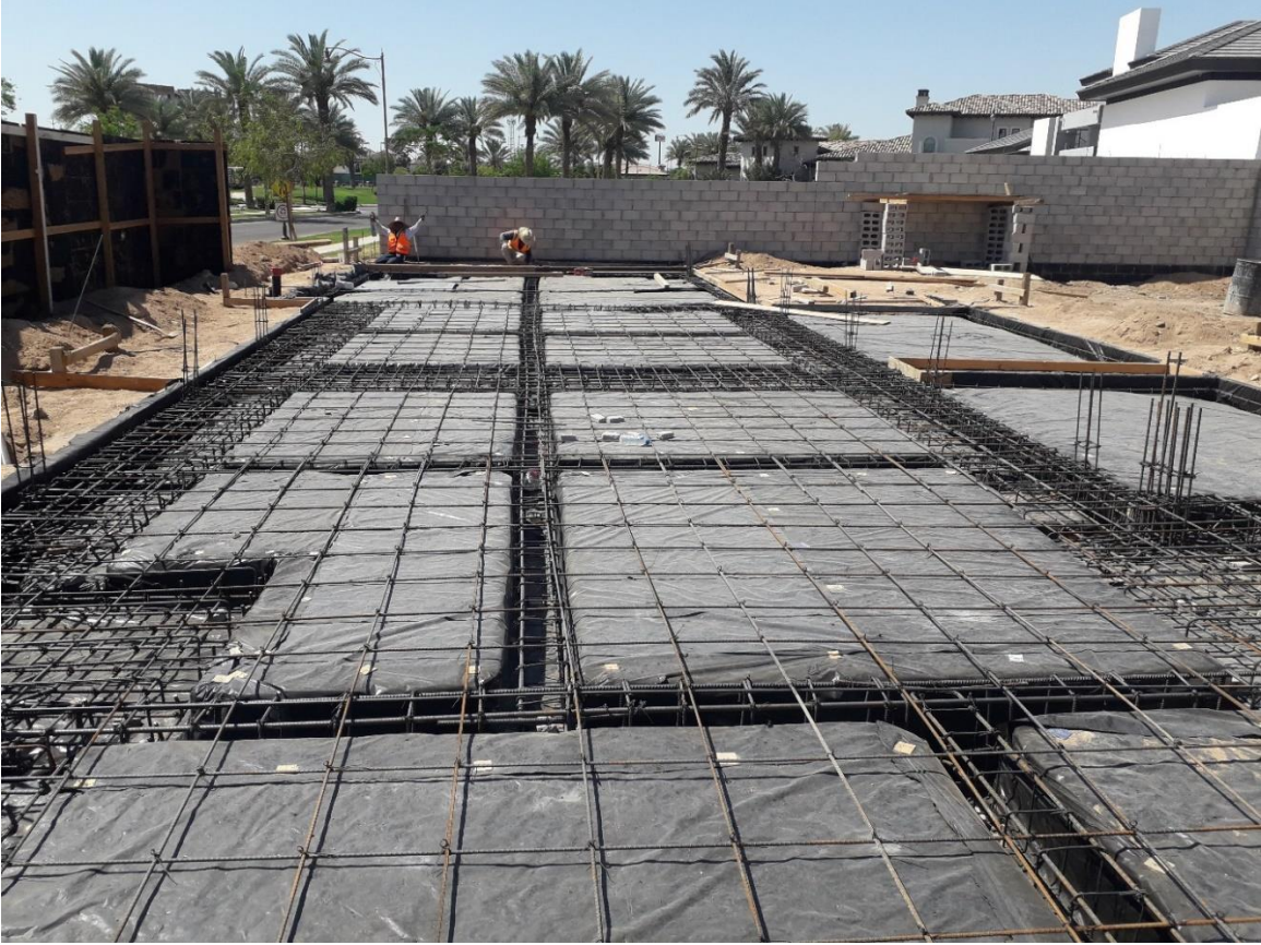
Imagen 20 Colocación de acero de refuerzo para cimentación.
