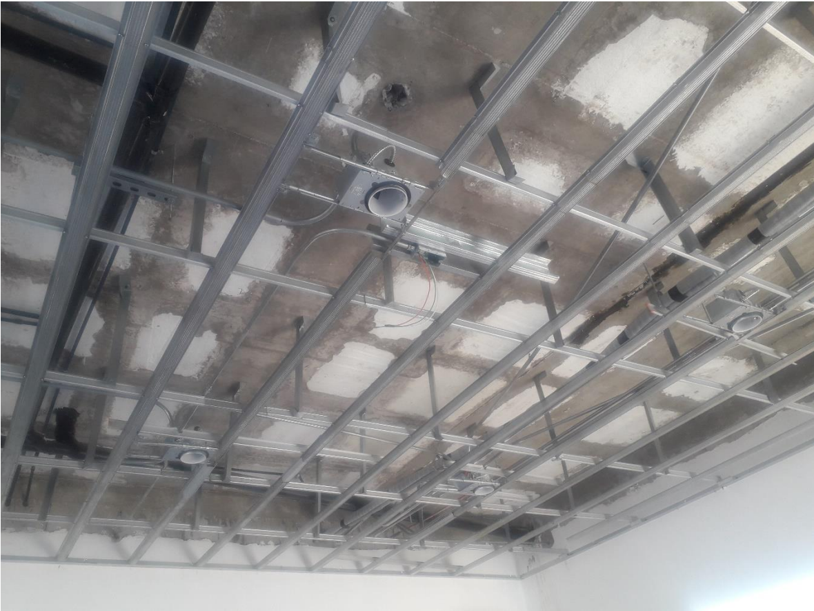
Imagen 34 Tuberías de acero galvanizado para instalaciones eléctricas.
