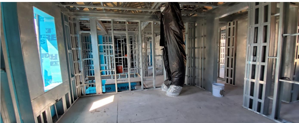
Imagen 10 Vista del acero montado en segunda planta
