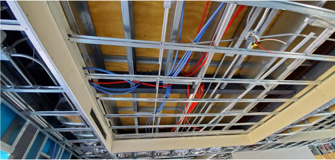
Imagen 15 instalaciones eléctricas sobre estructura de plafones.
