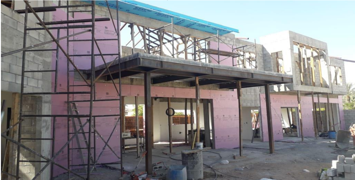
Imagen 37 Fijación de hoja de poli estireno extruido sobre muro de block.
