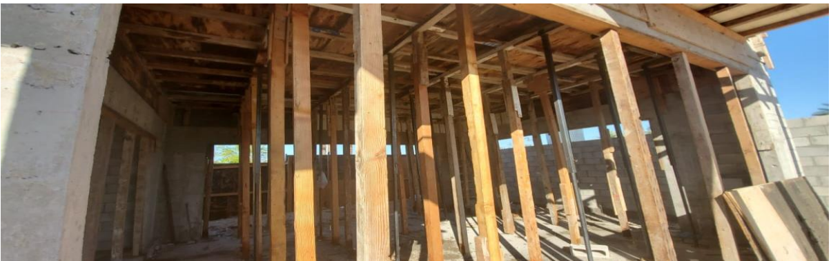
Imagen 25 Puntales de acero y madera en cimbra de entrepiso.
