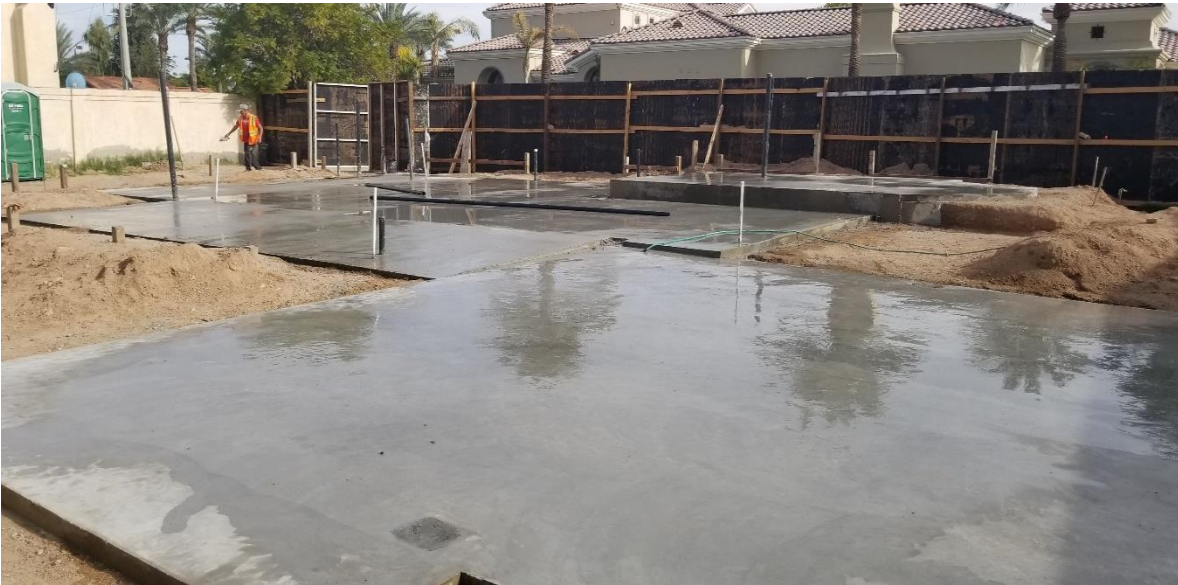
Imagen 3 Curado de losa de cimentación.
