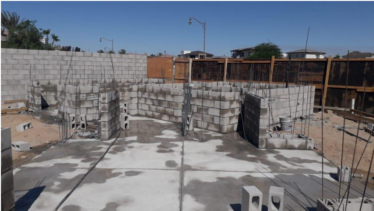
Imagen 23 Avance de colocación de block en muros.
