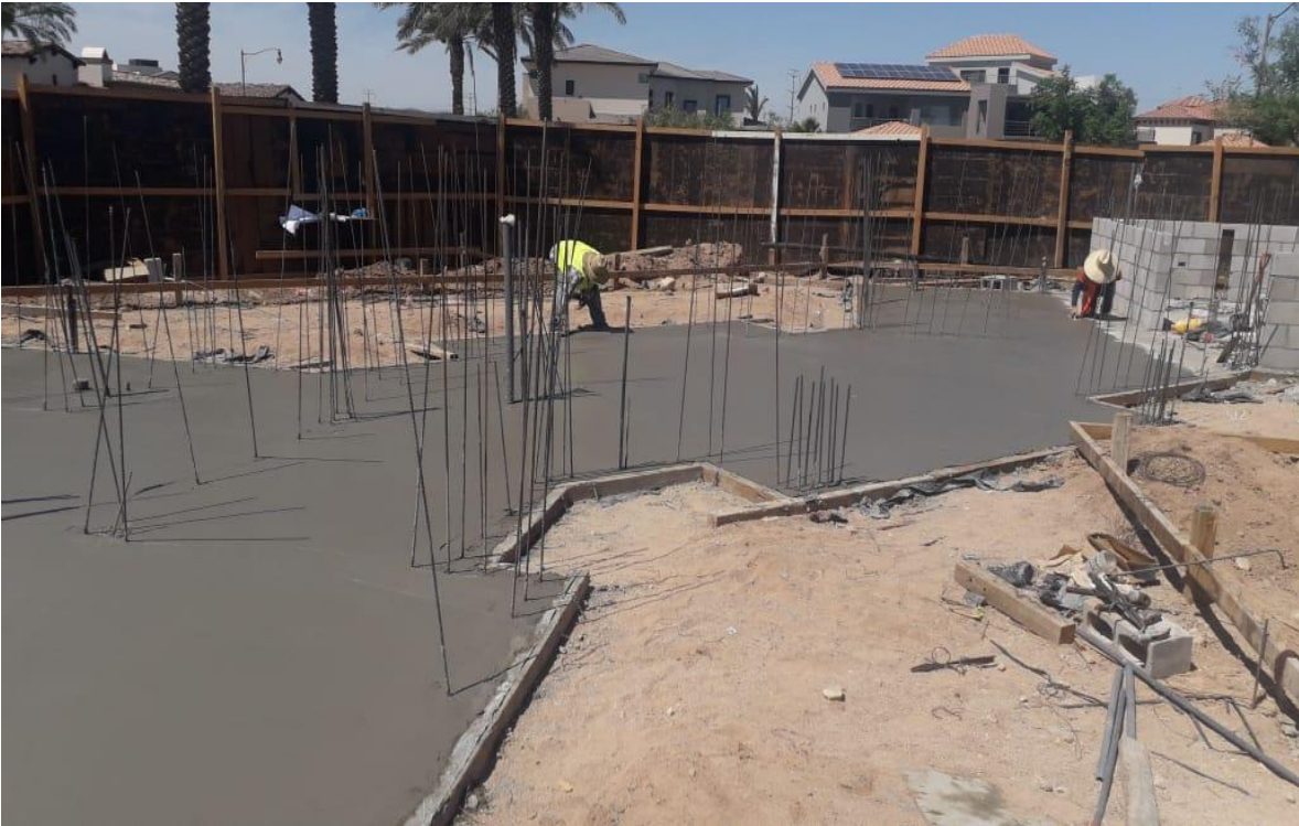
Imagen 22 losa de cimentación finalizada con acero de refuerzo vertical para muros .
