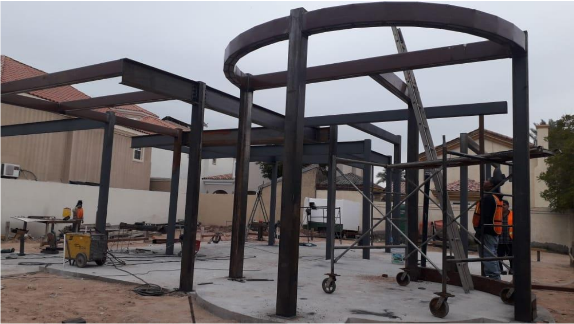
Imagen 5 Montaje de traves principales.
