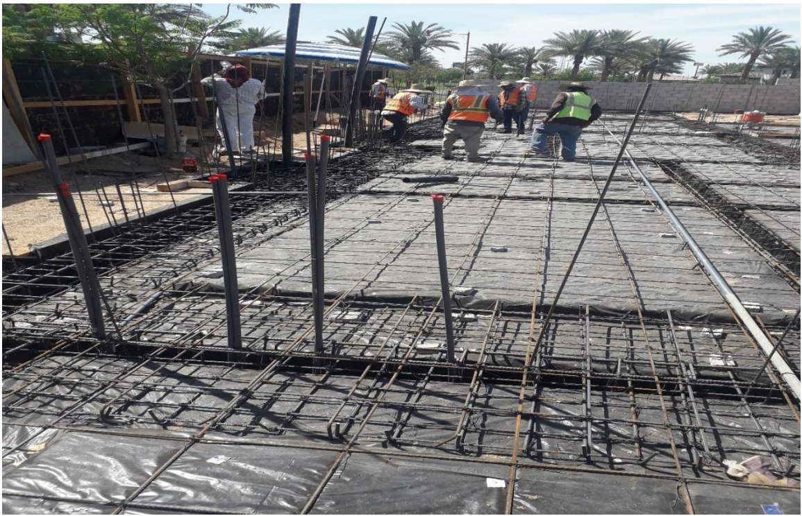
Imagen 21 colocación de tubería para instalaciones eléctricas.
