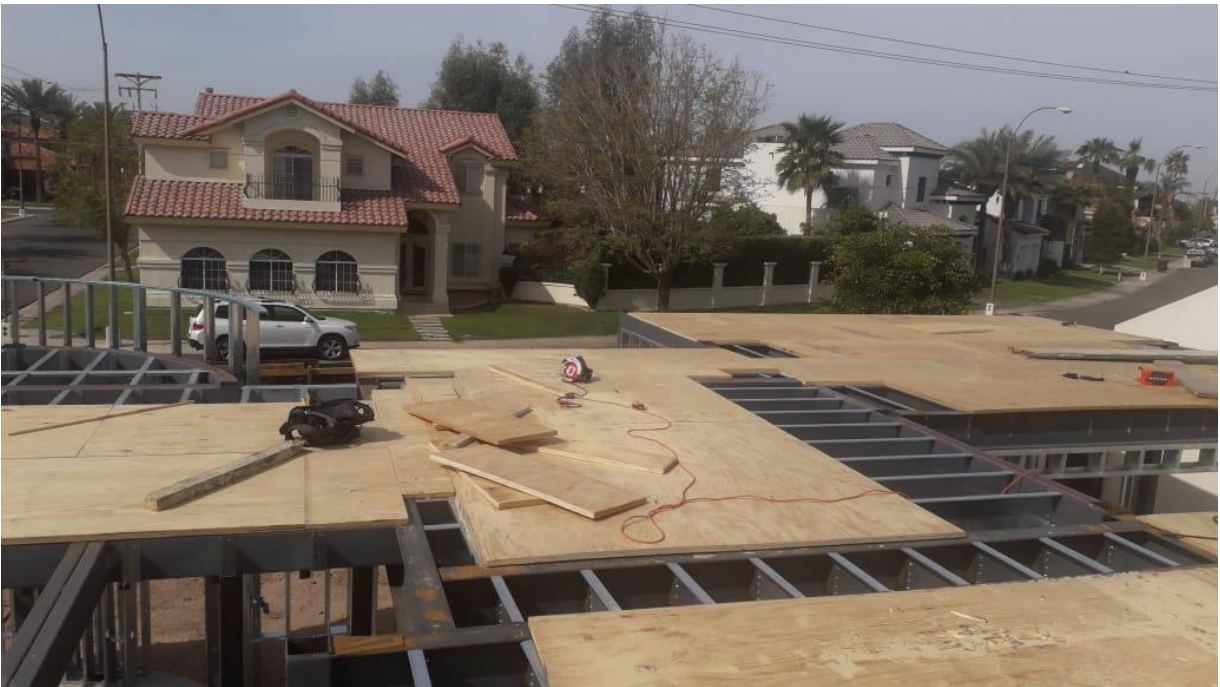
Imagen 6 Colocación de triplay de petatillo de 1-1/8 sobre polines de estructura principal
