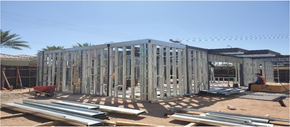
Imagen 8 Colocación de refuerzo horizontal sobre muros.
