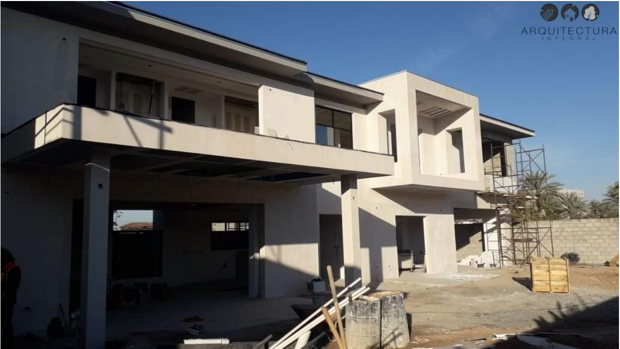
Imagen 38Acabado final, con pintura exterior
