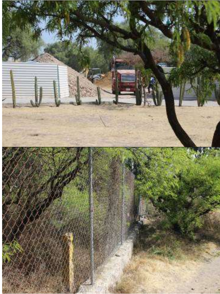
Figura. 4.2 Inicio de la construcción del planetario y barda perimetral, 2020.
