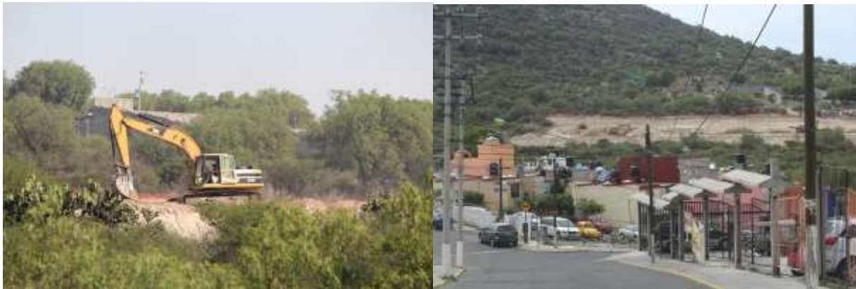
Figura 4.1. Construcción del Lago Ehécatl, (Sosa, 2017).
