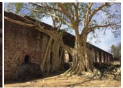
(3) Foto Tomada en Sitio: Extremo sur occidente del acueducto
