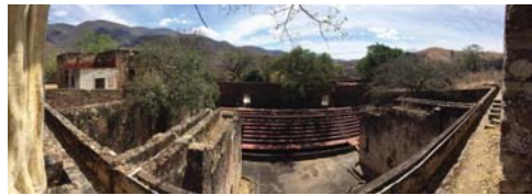
(2) Foto Tomada en Sitio: Patio de los molinos, se pretende hacer de este lugar un espacio al aire libre
