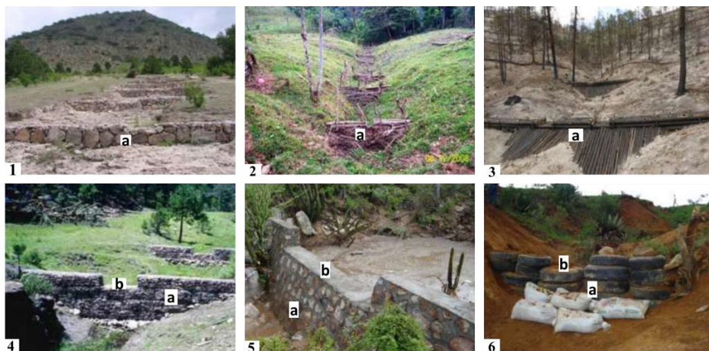
Figura 5.15. Tipos de presas para retención de suelo. 1) Presas de rocas de la zona. 2) Presas de material vegetal muerto. 3) Presa de madera resultado de aclareo. 4) Presa de maya de alambre soldada rellena de rocas. 5) Presa de mampostería 6) Presa de llantas. En las fotografías se señalan: a) presa, b) vertedero. Fotografías de Cuevas et al. , 2015.
