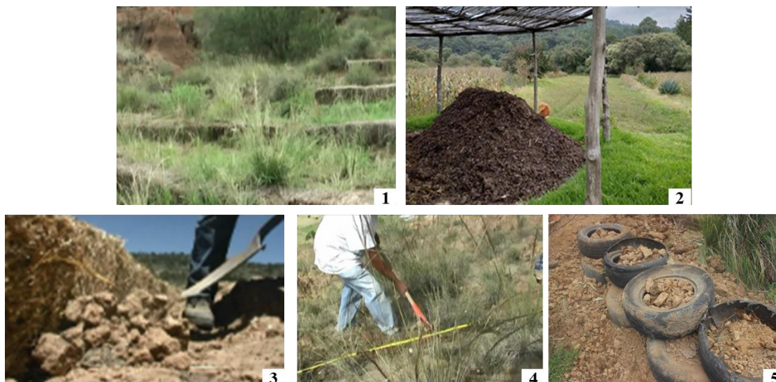
Figura 5.8. Acciones de rehabilitación realizadas en el proyecto San Isidro. 1) Barreras en curvas de nivel hechas de paja y rocas, 2) composta de residuos de plantaciones y estiércol, 3) presas en cárcavas conformadas de cuadros de paja y rocas, 4) construcción de zanjas y bordos en curvas de nivel y 5) presas de llantas llenas de rocas en presas. Fotografías del banco de imágenes del proyecto PN218.
