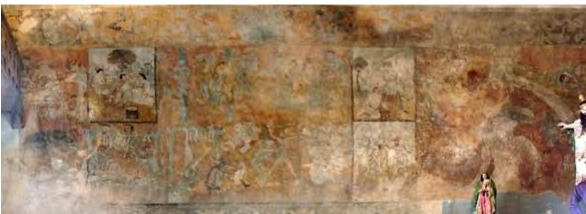
Ilustración 9.71. Pintura en el muro del evangelio en la iglesia de Santa María Xoxoteco, Hidalgo. Fotografía Aban Flores Morán (2018).
