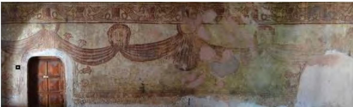
Ilustración 4.60. Lugar donde se tomó la muestra del rojo de hierro en la jamba izquierda del cuarto anexo a la celda prioral del convento de San Miguel Arcángel Tlaltizapán, Morelos. Fotografía Aban Flores Morán (2018)
