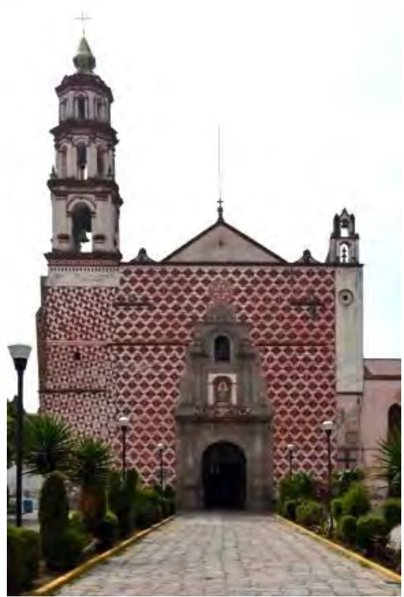
Ilustración 8.15. Iglesia de la Asunción Amecameca, Estado de México. Fotografía Aban Flores Morán (2010).
