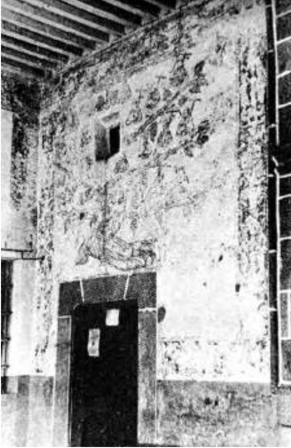
Ilustración 6.17. El árbol de san Francisco en el portal de peregrinos del convento de San Miguel Zinacantepec, Estado de México, a inicios del siglo XX.
