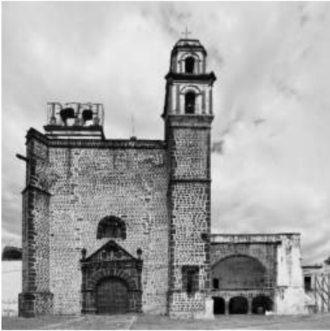
Ilustración 6.4. Iglesia y capilla abierta integrada como balcón en el convento de la Asunción Tochimilco, Puebla. Fotografía Aban Flores Morán (2010).
