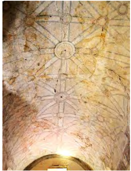
Ilustración 7.34. Bóveda de cañón corrido en la iglesia de la Asunción Cuernavaca, Morelos. Fotografía Aban Flores Morán (2018)
