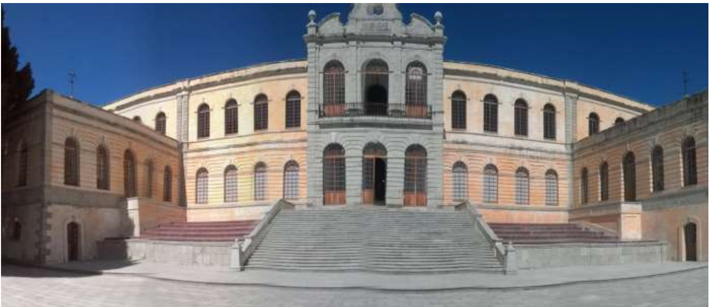
Fábrica de hilados y tejidos de San José Etla, en Valles Centrales: destino final del algodón costeño (Como se conserva actualmente, fotografía de Álvaro E. García Robledo)
