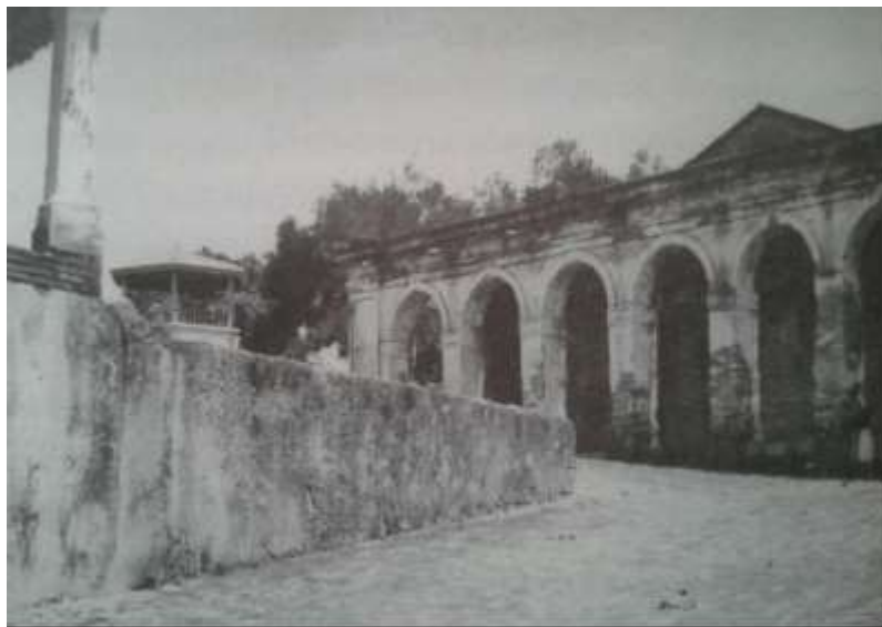
Vestigio de la tienda de Dámaso Gómez en el centro de Jamiltepec como podía verse hace apenas unas décadas.
