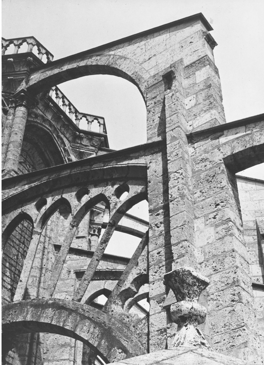
Fig. 3.6 Arbotantes en la catedral de Chartres colocados en distintas épocas como respuesta a desplazamientos en los sillares
