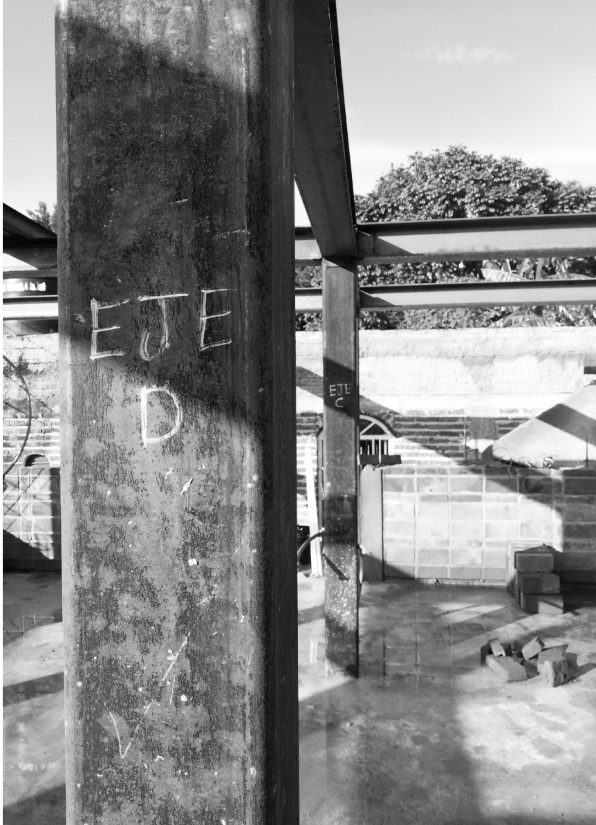
Fig. 4.8 Signos utilizados en obra para guiar las acciones de los constructores en referencia a las designaciones del proyecto
