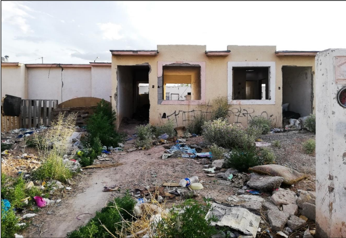
Imagen 6.19 y 6.20. Viviendas desmanteladas en Las Haciendas
