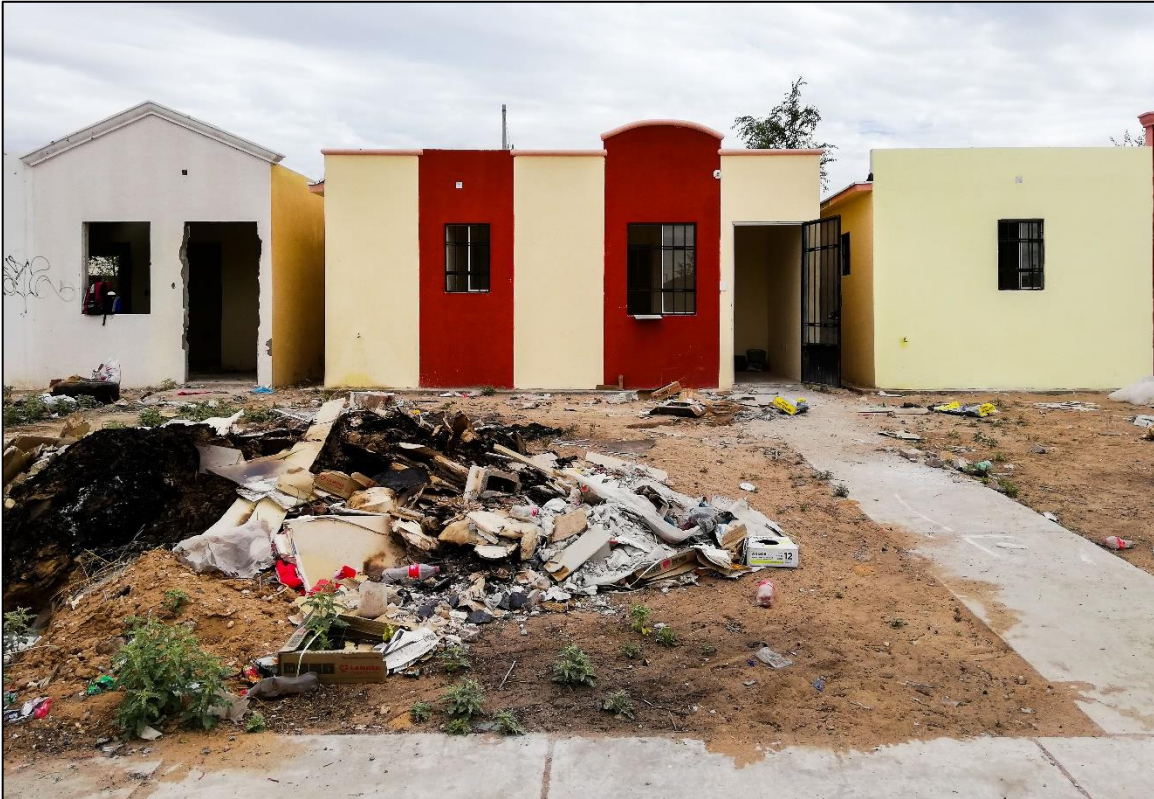
Imagen 6.35 y 6.36. Intervención de viviendas recuperadas
