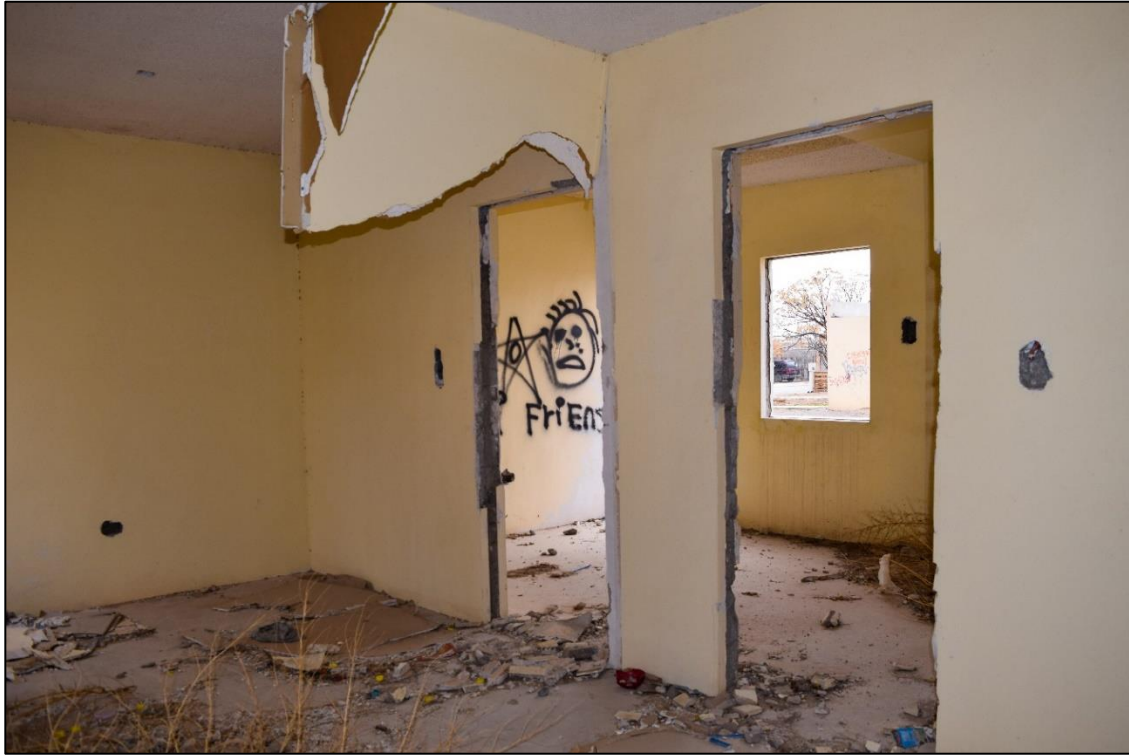
Imagen 6.17 y 6.18. Viviendas desmanteladas en Senderos de San Isidro
