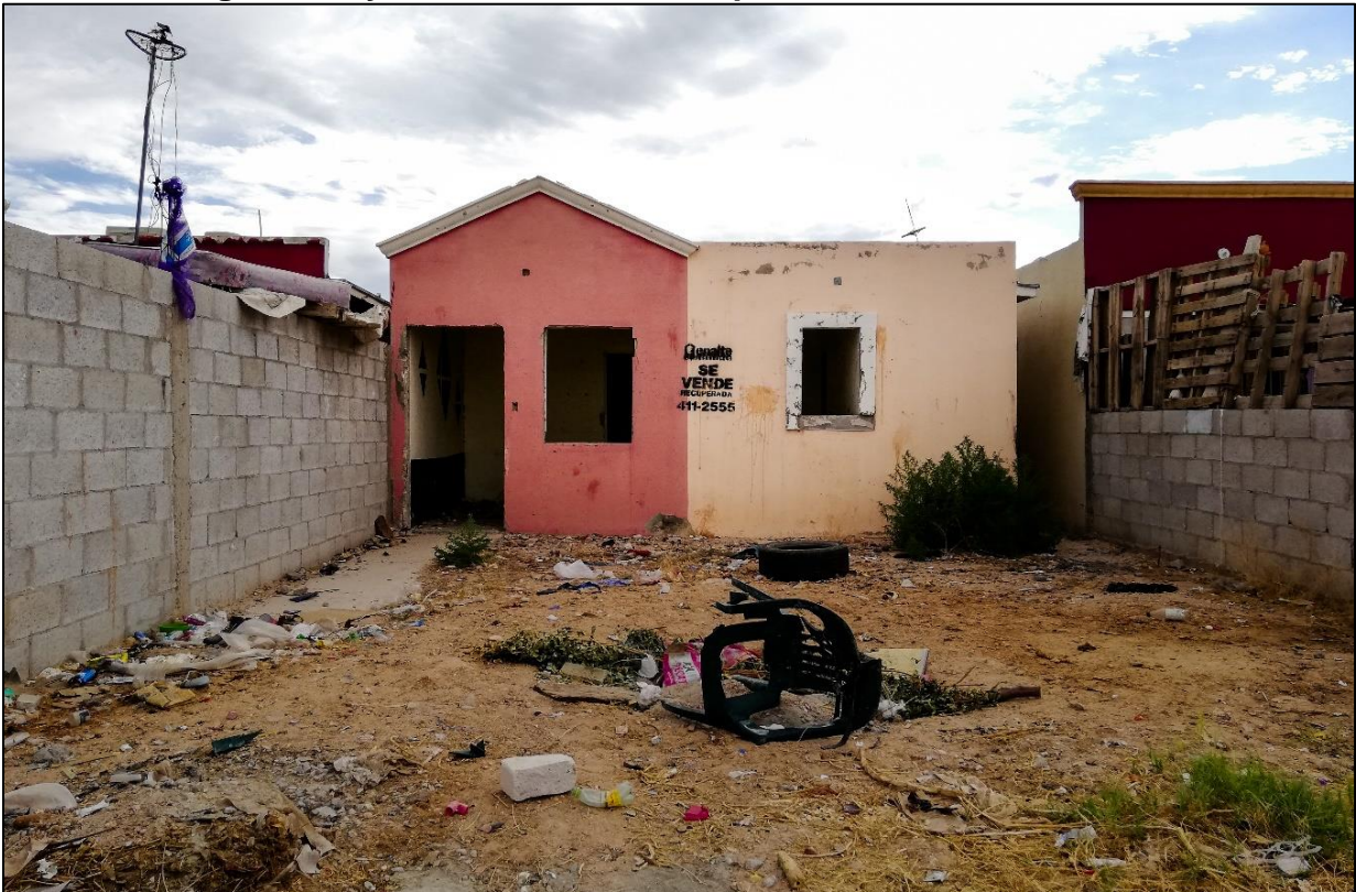
Imagen 6.31 y 6.32. Viviendas recuperadas sin intervención
