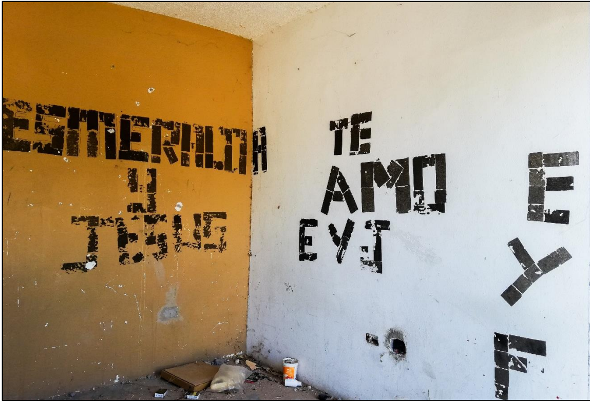
Imagen 6.13 y 6.14. Interior de viviendas vandalizadas
