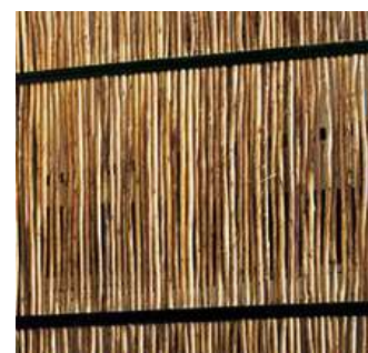
Sección de muro de carrizo sujeto a estructura de acero perteneciente al Hotel Indigo Patagonia Puerto Natales, Patagonia Chile Autor de fotografía: Cristóbal Palma
