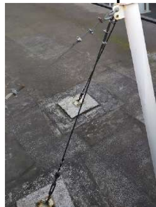
Elementos estructurales velaria CNA. Anclaje de columna desde la parte superior al suelo mediante tensores que la mantienen con una inclinación de aproximadamente 70°. Foto Melissa Delgado
