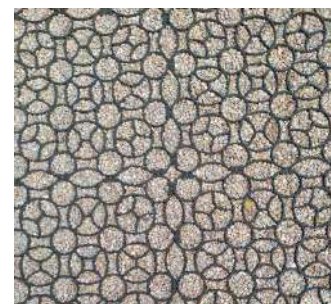
Célula de drenaje en Paseo de la Reforma CDMX. Autor: Melissa Delgado
