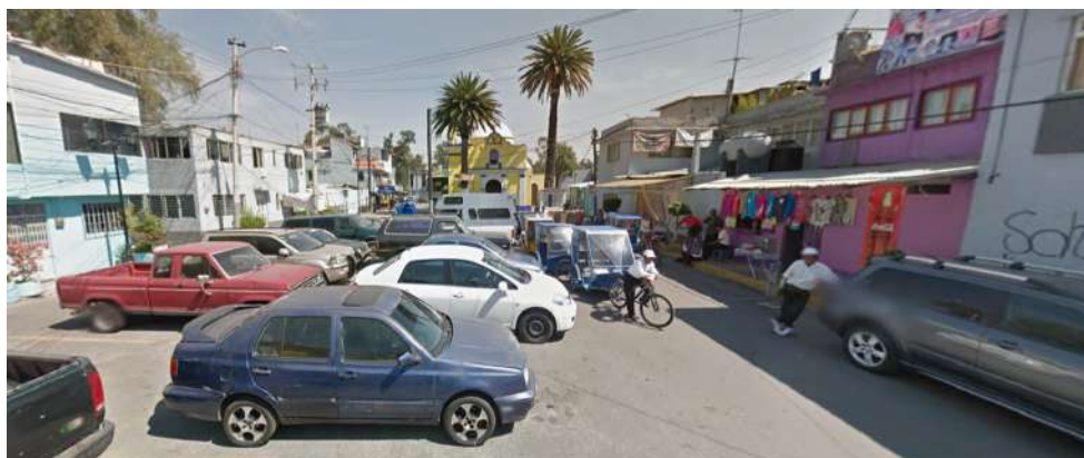
Foto 31. Estado actual de atrio Barrio La Santísima, Xochimilco, degradación del espacio, transformación del espacio público en estacionamientos. Fuente: Google Street view.
