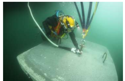
Foto 58. Anclaje de "The Floating Piers" a muerfos de concreto en el fondo del Lago Iseo. Fuente: Christo and Jeanne Claude
