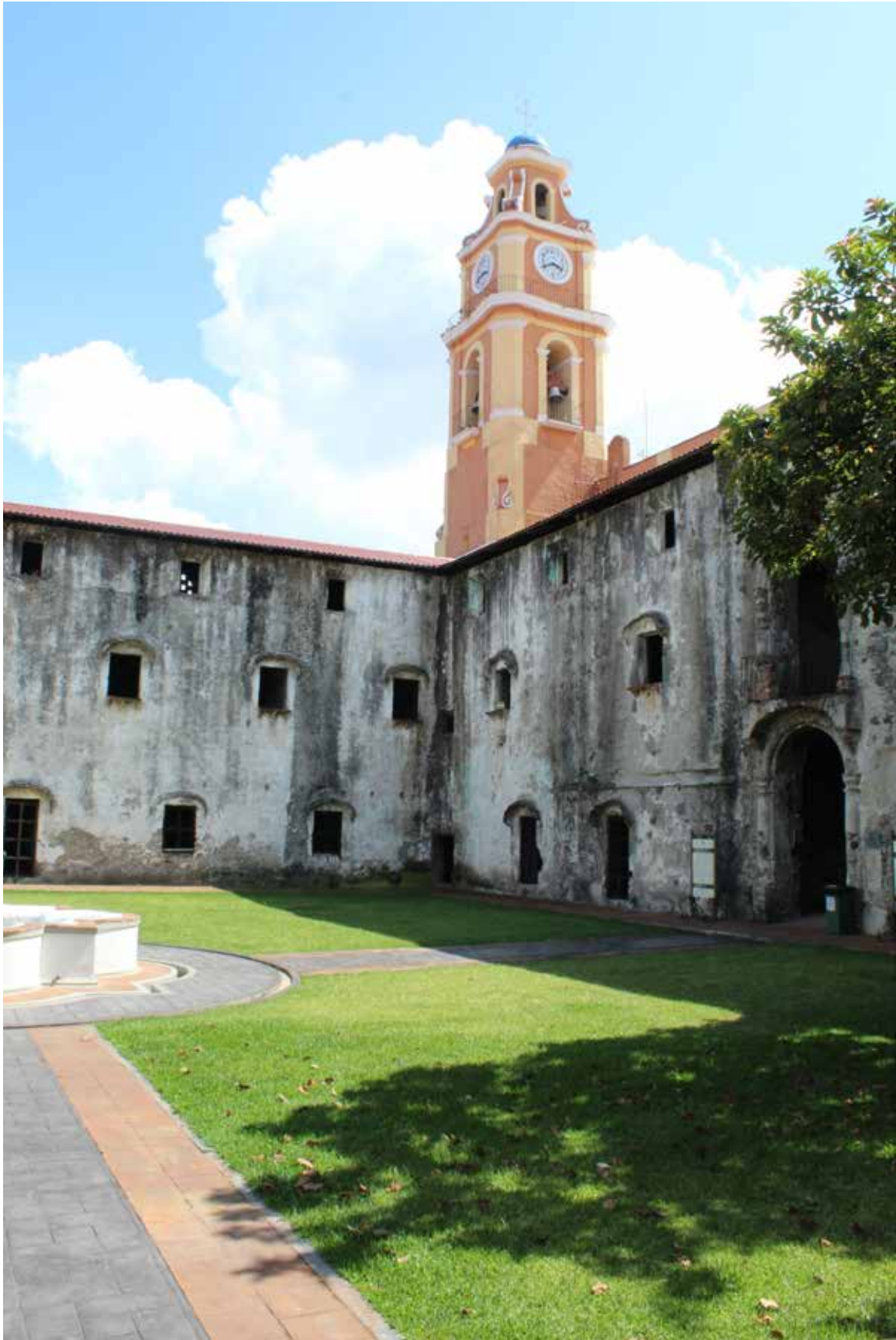
Imagen 29: Patio del claustro del Convento de San José de Gracia . Fuente: Elaboración propia.
