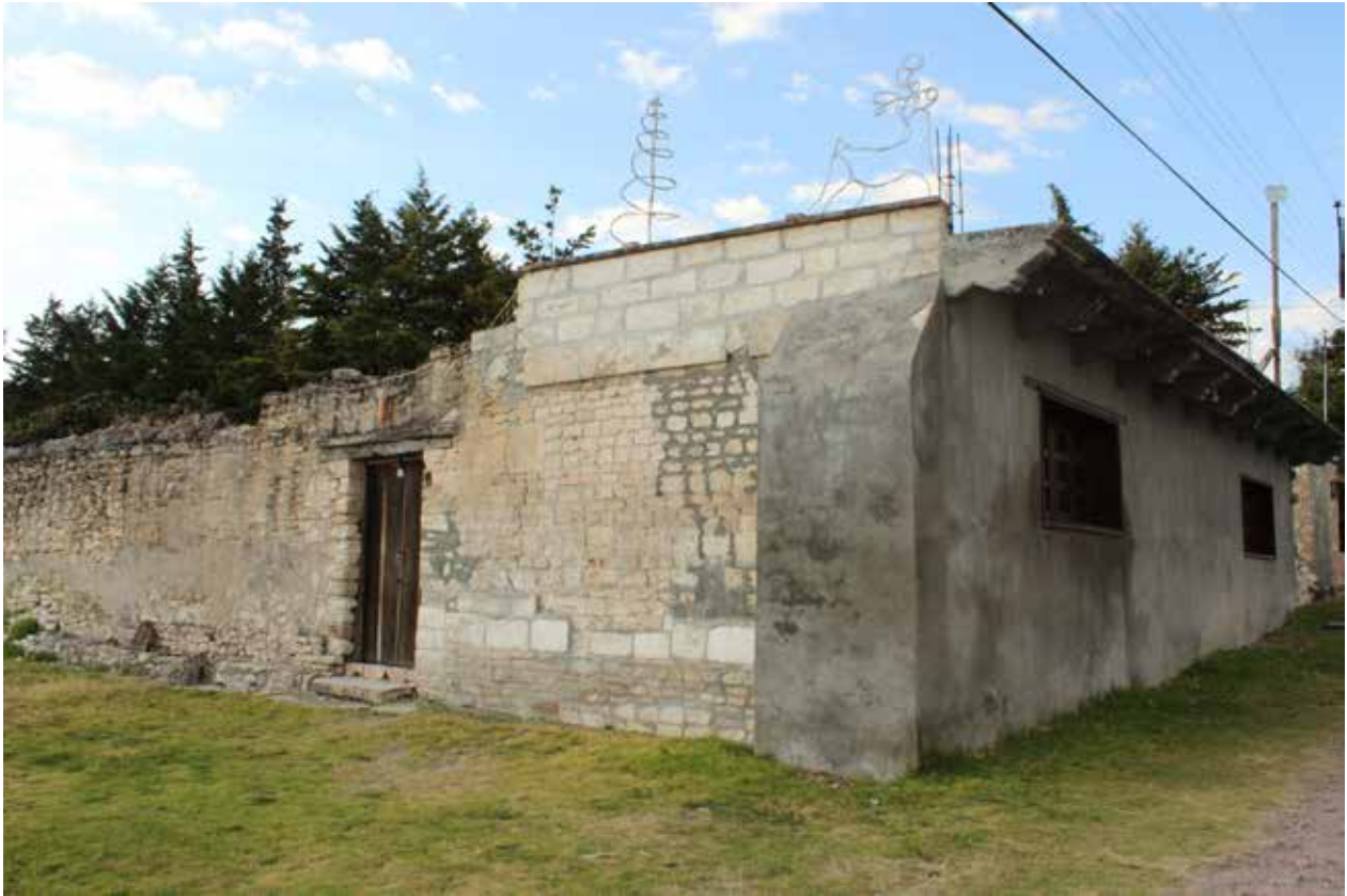
Imagen 8: Transformación de vivienda tradicional catalogada por el INAH en San Pedro y San Pablo Teposcolula, Oaxaca. Fuente: Elaboración Propia.
