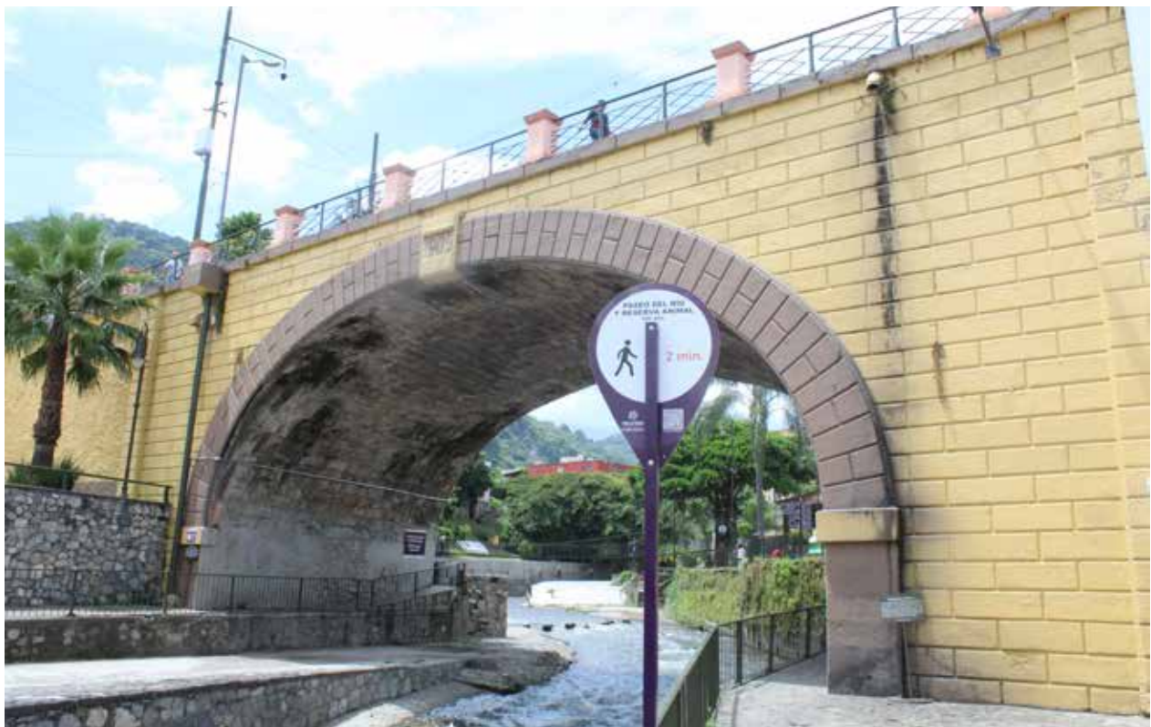
Imagen 27:Puede en el paseo del río Orizaba en la sección del CH, también los puentes siguen el código de color establecido para las fachadas. Fuente: Elaboración propia.
