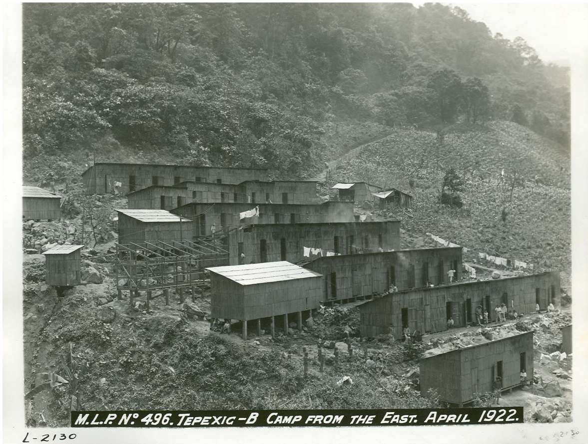
Fig. 24. Campamento de trabajadores en Tepexic (1922).
