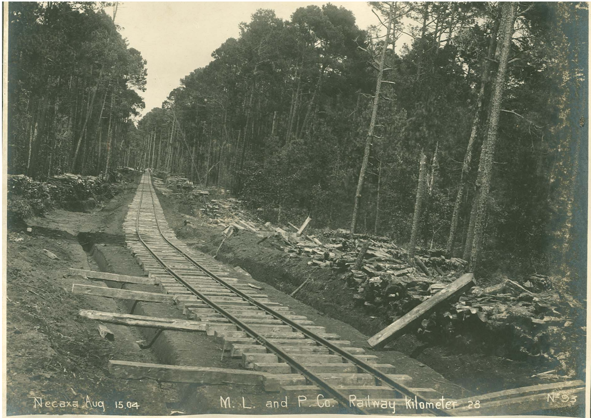
Fig. 21. Uso de madera durante la construcción del ferrocarril Beristáin-Necaxa (1904)
