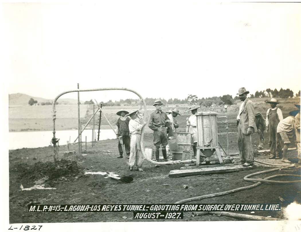
Fig. 18. Obras hidráulicas entre las presas de Laguna y Los Reyes (1927).
