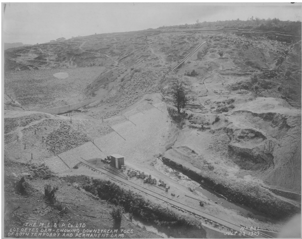
Fig. 20. Suelo erosionado alrededor de la presa de Los Reyes (1909).
