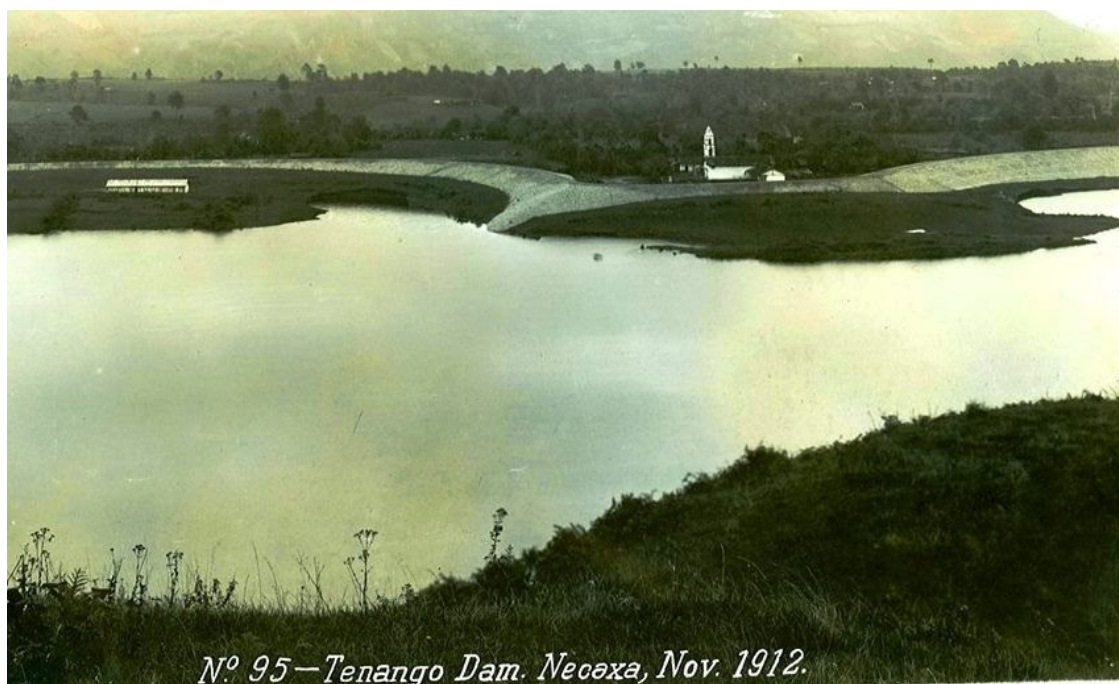
Fig. 16. Presa de Tenango (1912).
