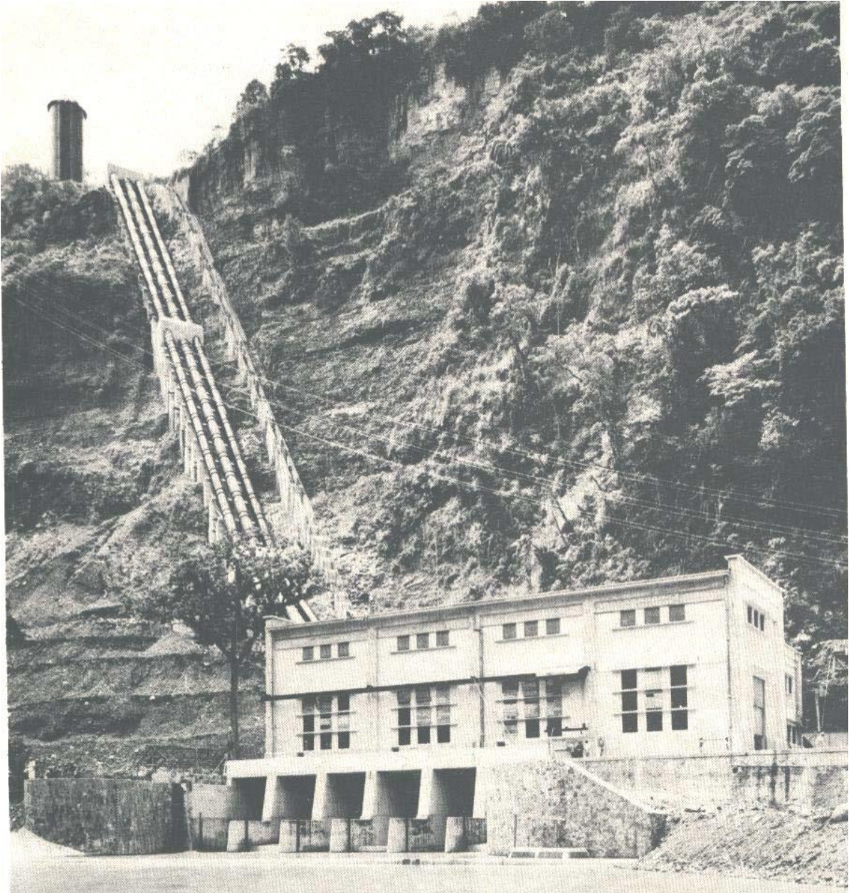
Fig. 7. Central hidroeléctrica de Patla (1954).
