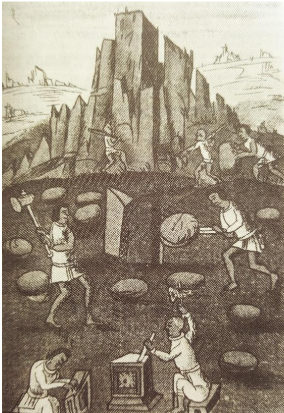
Figura III-C Canteros y albañiles indígenas. Según Sahagún. Imagen tomada del libro: Kubler, G. (1983). Arquitectura mexicana del siglo XVI . (R. De la Torre, G. de Garay, & M. de Quevedo, Trads.) México: Fondo de Cultura Económica.
