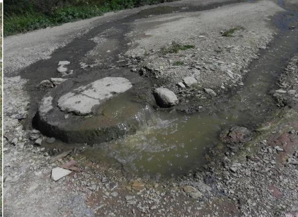
*Figura 38. Fotografía de coladera con fuga de agua gris y negra, ubicada sobre el camino a la Hacienda de Santa Brígida. Propia, 2017.*
