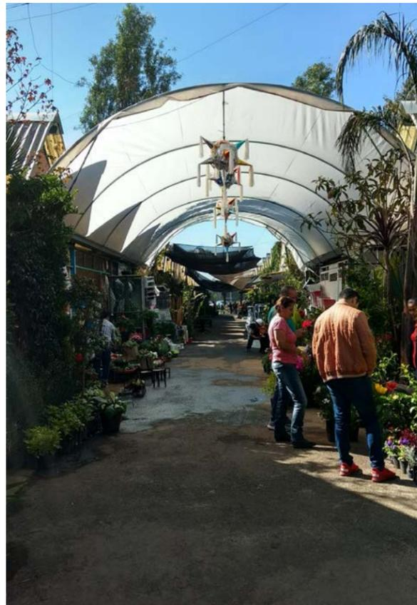
Imagen 41. Fotografía de cubierta con arcos tubulares en pasillo del mercado
