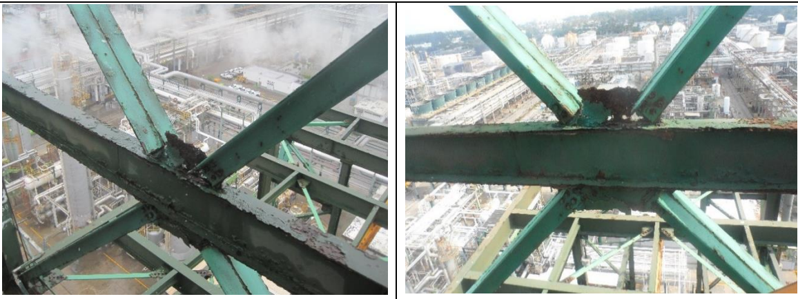
a) Contraventeos verticales y sus conexiones (Ayala y García, 2015)
