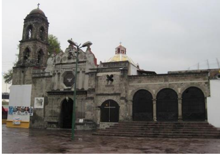
Figura 2.10. Fachada de la parroquia de San Bartolomé (Robles, 2013)
