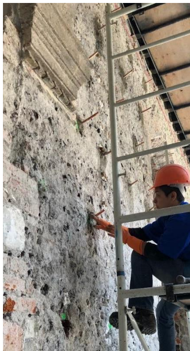
Figura 4.28. Colocación de ductos para inyección en un muro de mampostería
