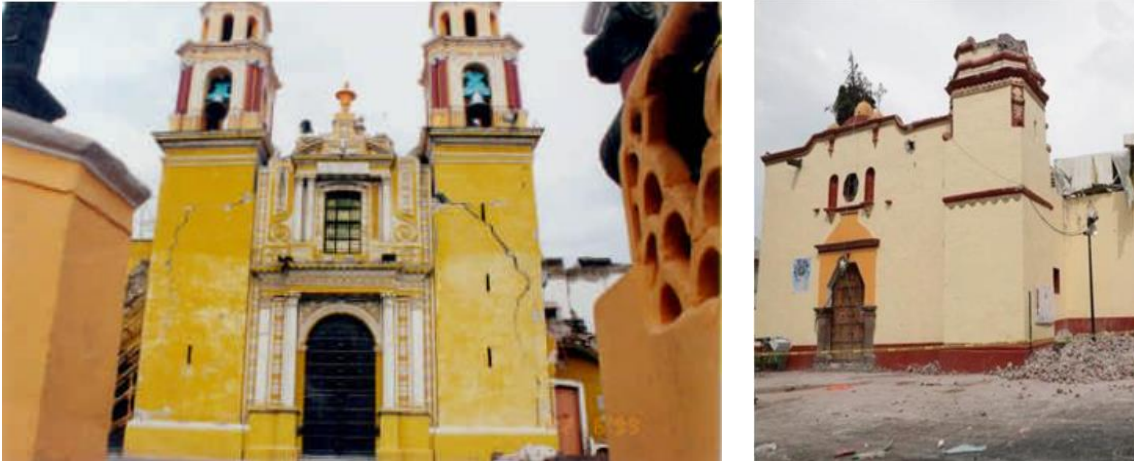
Figura 1.3. Daños a iglesias por sismo: a) agrietamiento inclinado y horizontal en torres de fachada de la iglesia de Nuestra señora de los Remedios, San Andrés, Cholula, Puebla, ocasionado por el sismo del 15 de junio de 1999 (Alcocer et al., 1999), b) colapso del campanario en la iglesia ubicada en Av. México Pte. y Av. Cuauhtémoc, Colonia San Gregorio Atlapulco, Delegación Xochimilco, CDMX; ocasionado por el sismo del 19 de septiembre de 2017 (Galicia, 2018)
