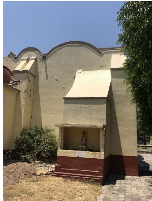
Figura 3.22. Grietas en unión Sagrario-Nave central: a) Agrietamiento en la unión Sagrario-Muro, b) Agrietamiento en conexión muro de Sagrario-Contrafuerte
