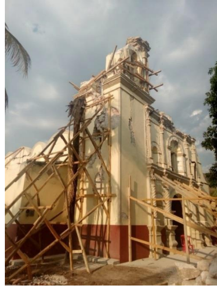
Figura 3.24. Daños en la torre: a) Daño en campanarios de la iglesia, b) Campanarios colapsados y grieta en cara Poniente de la torre
