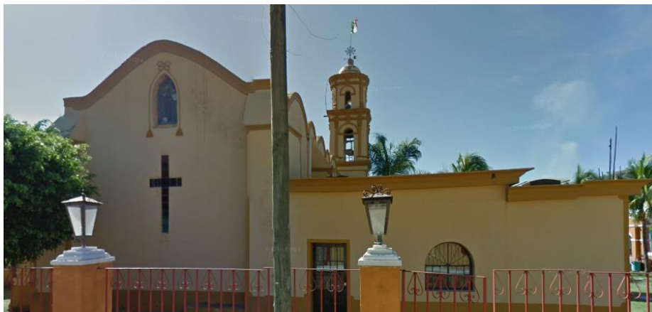
Figura 3.3. Fachada norte de la Iglesia de Pilcaya (Google, s.f a)
