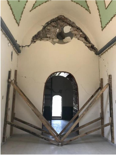
Figura 3.22. Grietas en unión Sagrario-Nave central: a) Agrietamiento en la unión Sagrario-Muro, b) Agrietamiento en conexión muro de Sagrario-Contrafuerte
