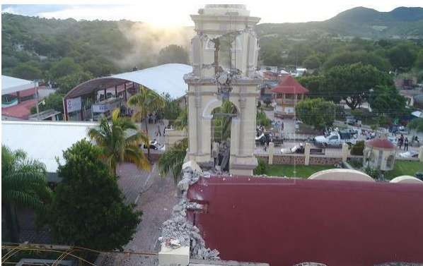
Figura 3.25. Daños en el campanario: a) Grietas en columnas y pérdida de material, b) Grietas en los dos cuerpos del campanario
