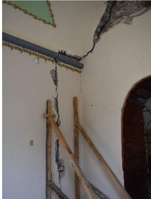
Figura 3.22. Grietas en unión Sagrario-Nave central: a) Agrietamiento en la unión Sagrario-Muro, b) Agrietamiento en conexión muro de Sagrario-Contrafuerte
