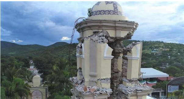
Figura 3.24. Daños en la torre: a) Daño en campanarios de la iglesia, b) Campanarios colapsados y grieta en cara Poniente de la torre
