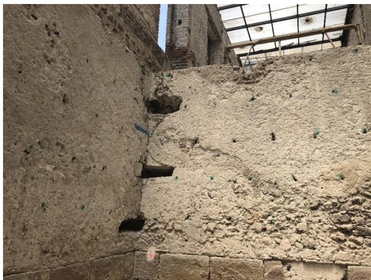
Figura 4.29. Huecos en conexión de muros perpendiculares para la colocación de lajas de recinto
